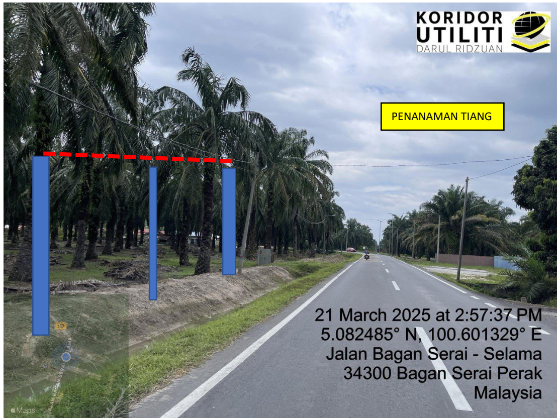
LOKASI DI JALAN BAGAN SERAI - SELAMA
