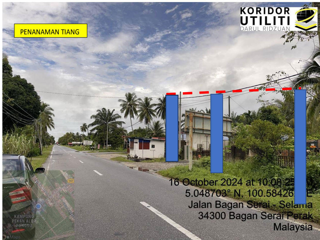
LOKASI DI JALAN BAGAN SERAI - SELAMA
