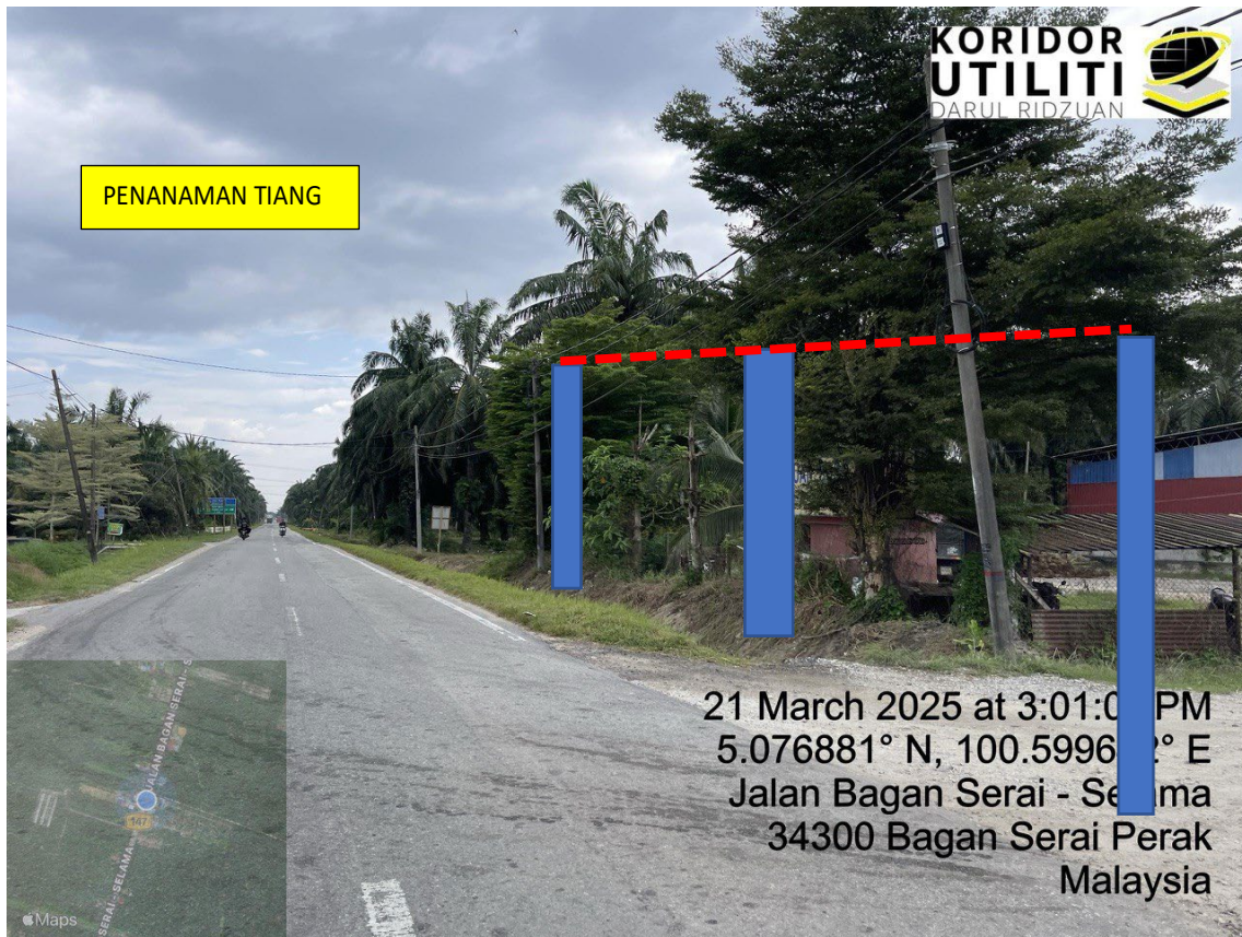
LOKASI DI JALAN BAGAN SERAI - SELAMA
