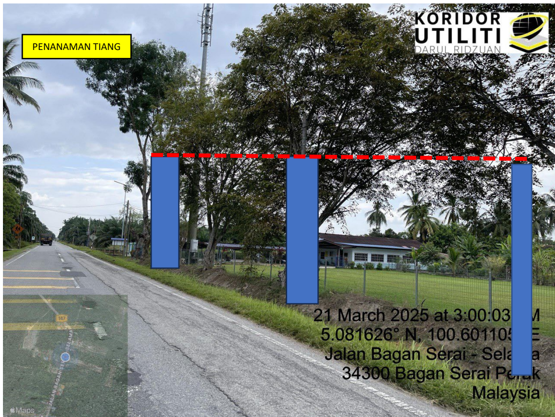
LOKASI DI JALAN BAGAN SERAI - SELAMA
