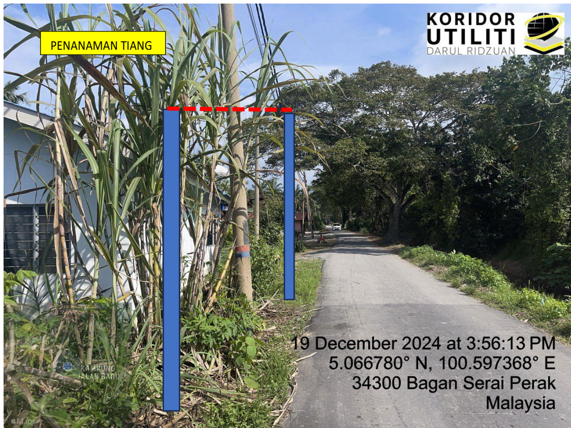
LOKASI DI JALAN KAMPUNG PARIT 2 JALAN BAHARU
