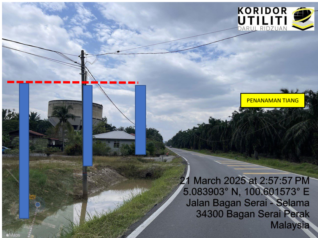
LOKASI DI JALAN BAGAN SERAI - SELAMA
