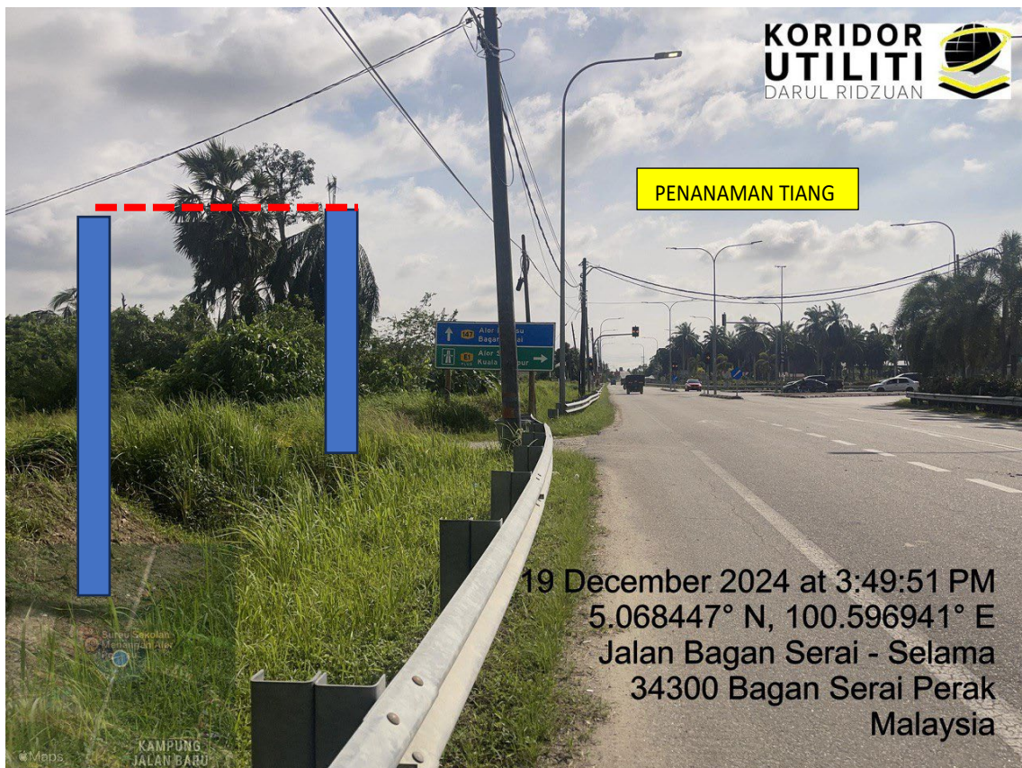
LOKASI DI JALAN BAGAN SERAI – SELAMA
