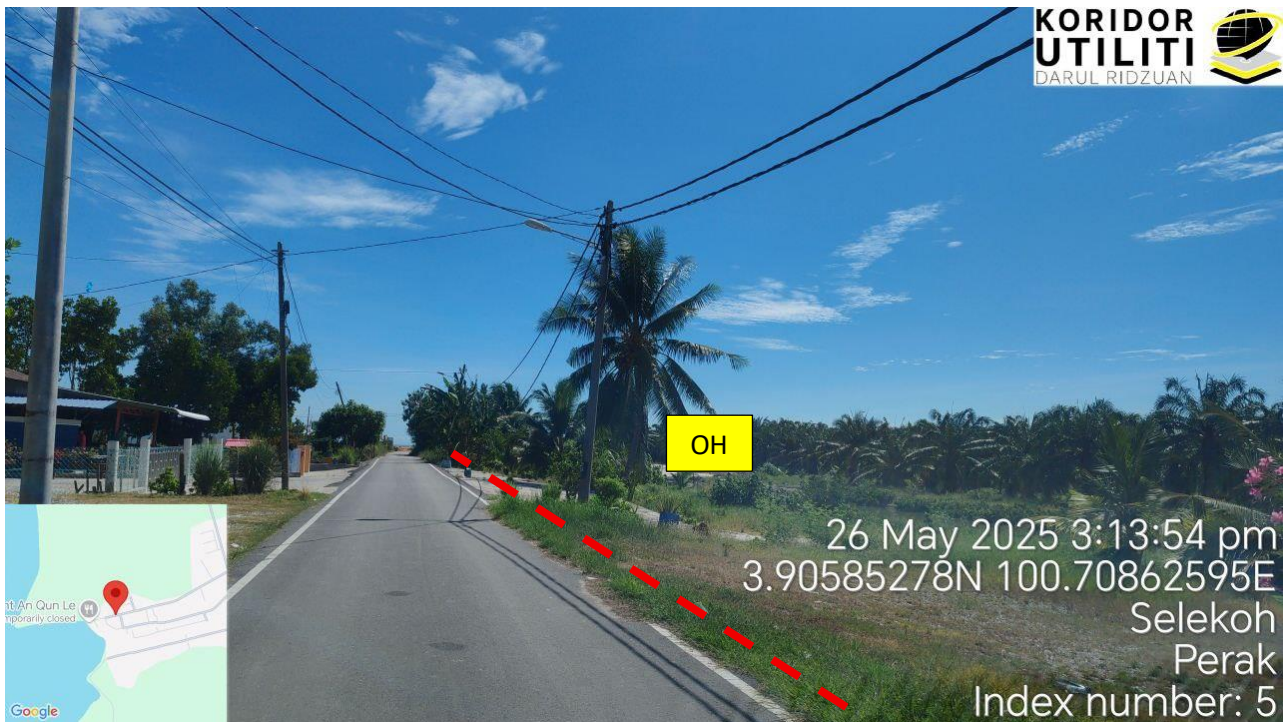
Jalan Kampung Sungai Tiang
