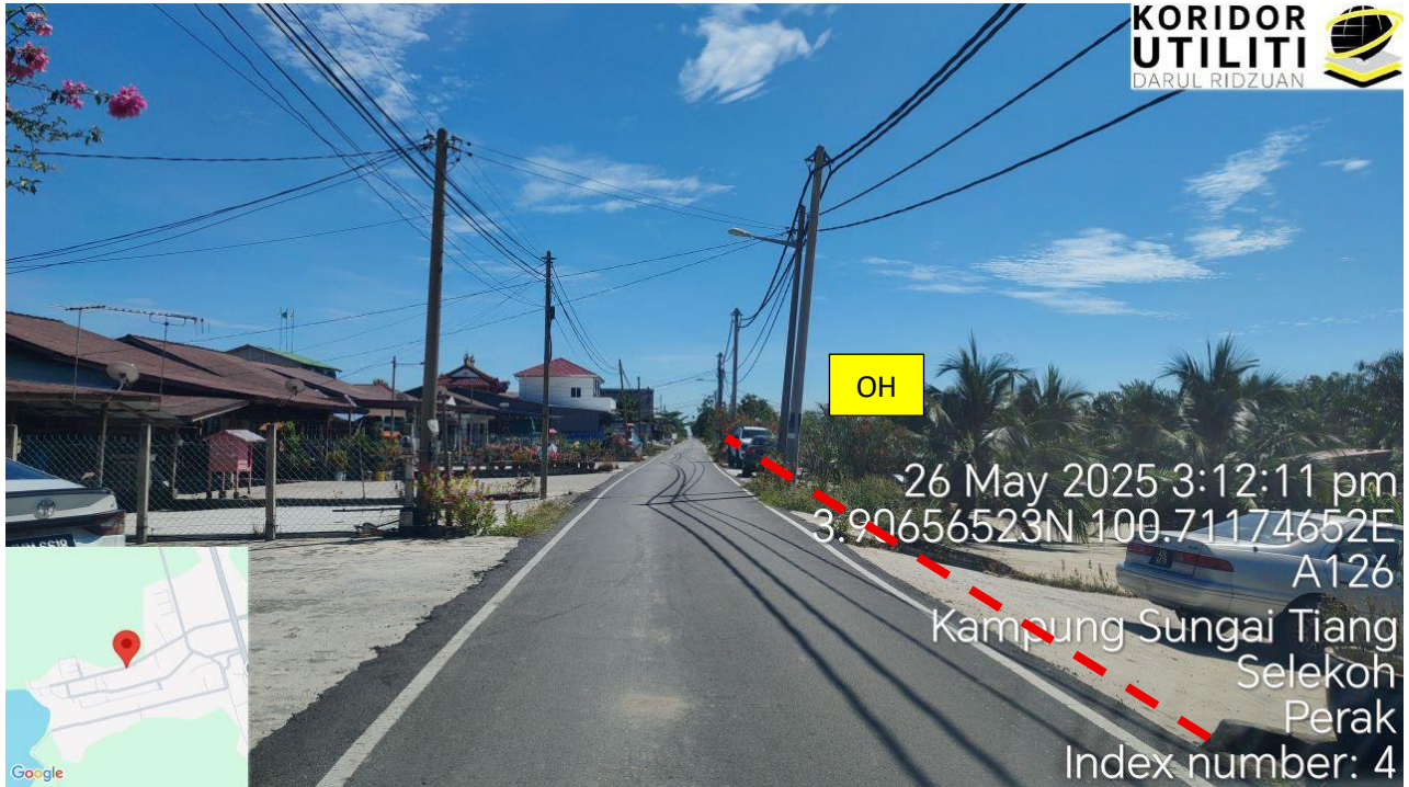
Jalan Kampung Sungai Tiang
