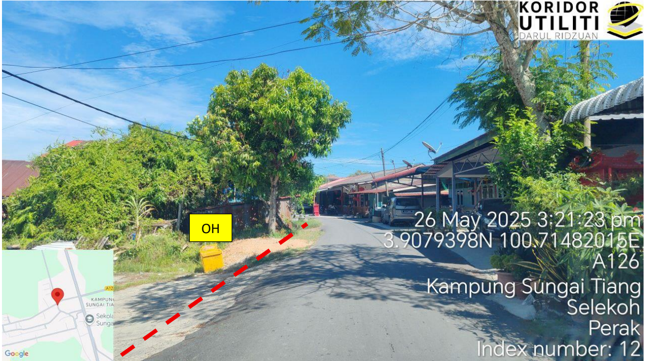
Jalan Kampung Sungai Tiang
