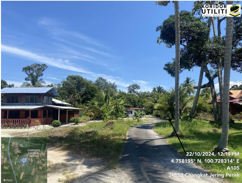
LALUAN PENANAMAN TIANG – JALAN KG CHENGAL JANTAN
