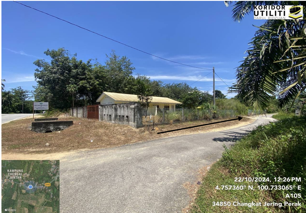
LALUAN PENANAMAN TIANG – JALAN KG CHENGAL JANTAN
