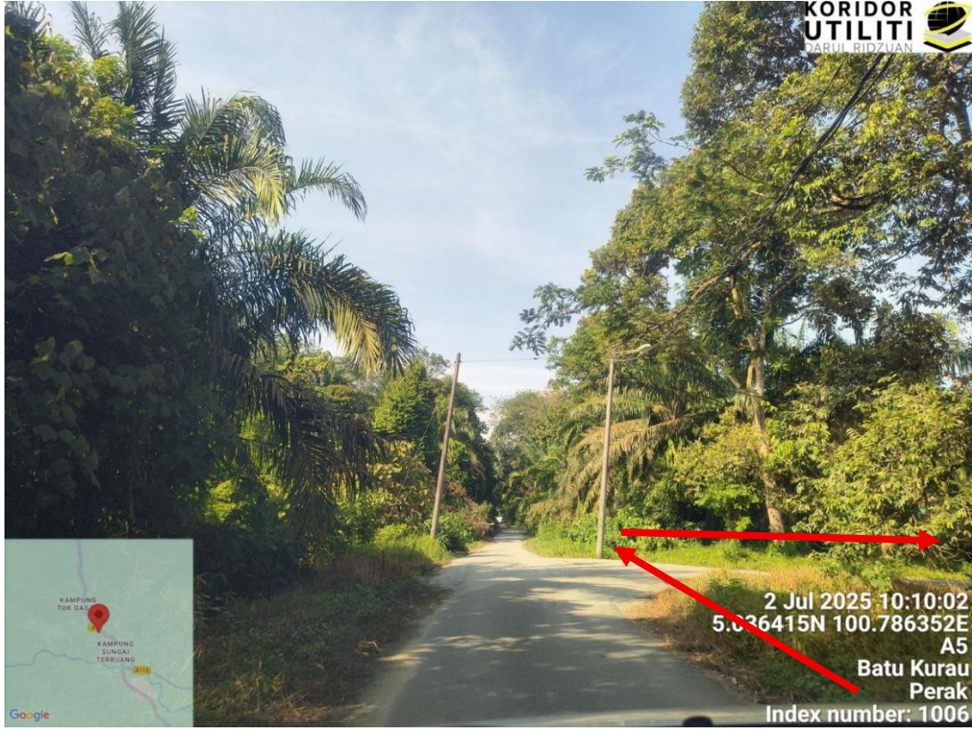
CADANGAN PENANAMAN TIANG DI JALAN PDT
