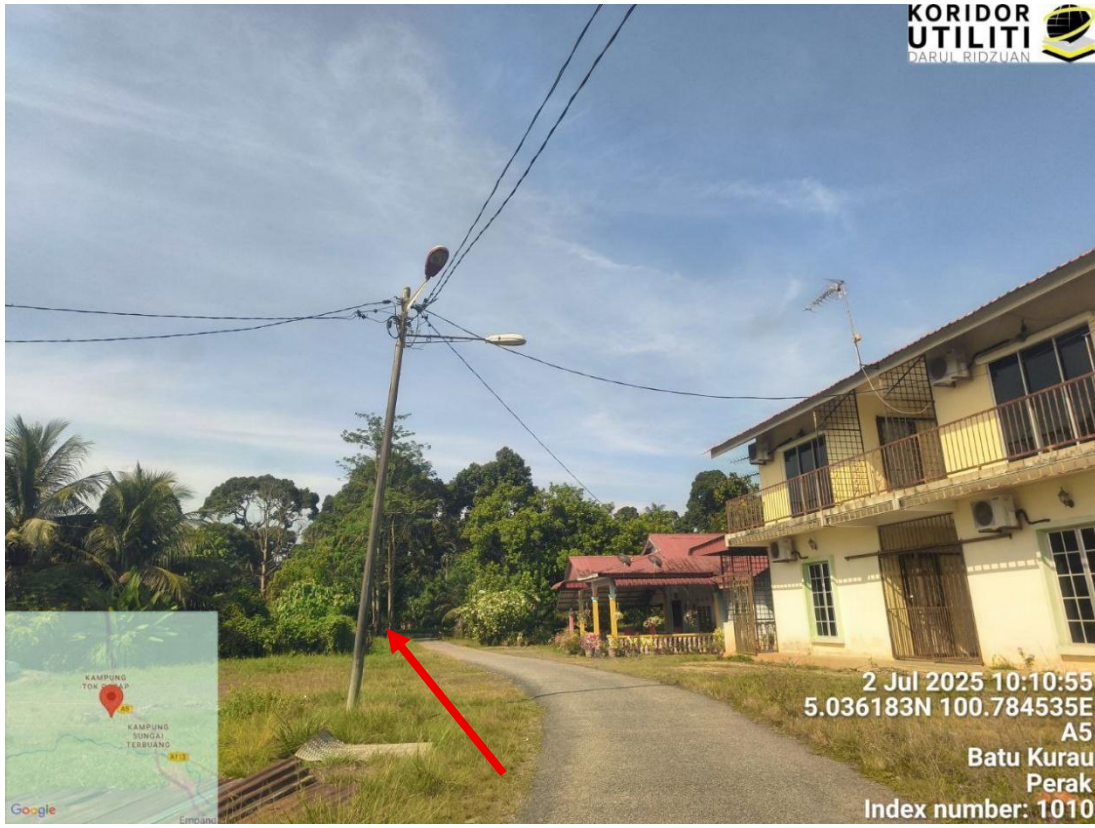
CADANGAN PENANAMAN TIANG DI JALAN PDT
