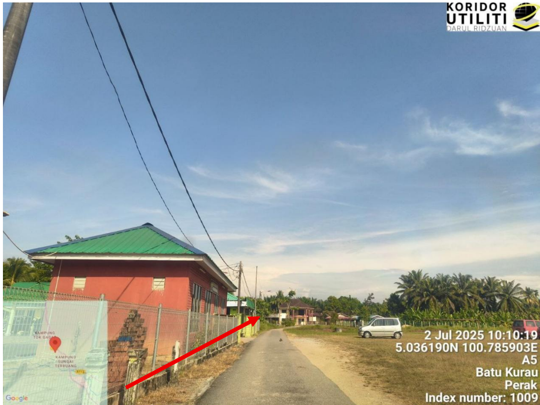
CADANGAN PENANAMAN TIANG DI JALAN PDT
