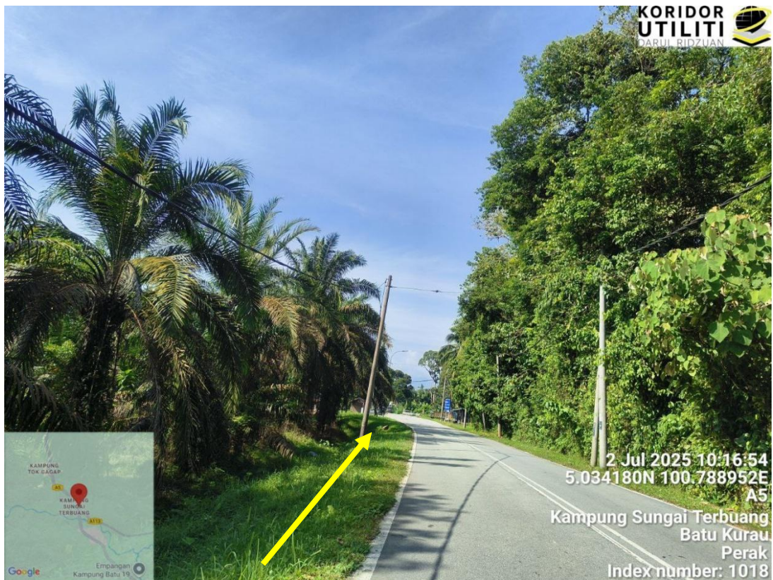
CADANGAN HDD DI JALAN JKR
