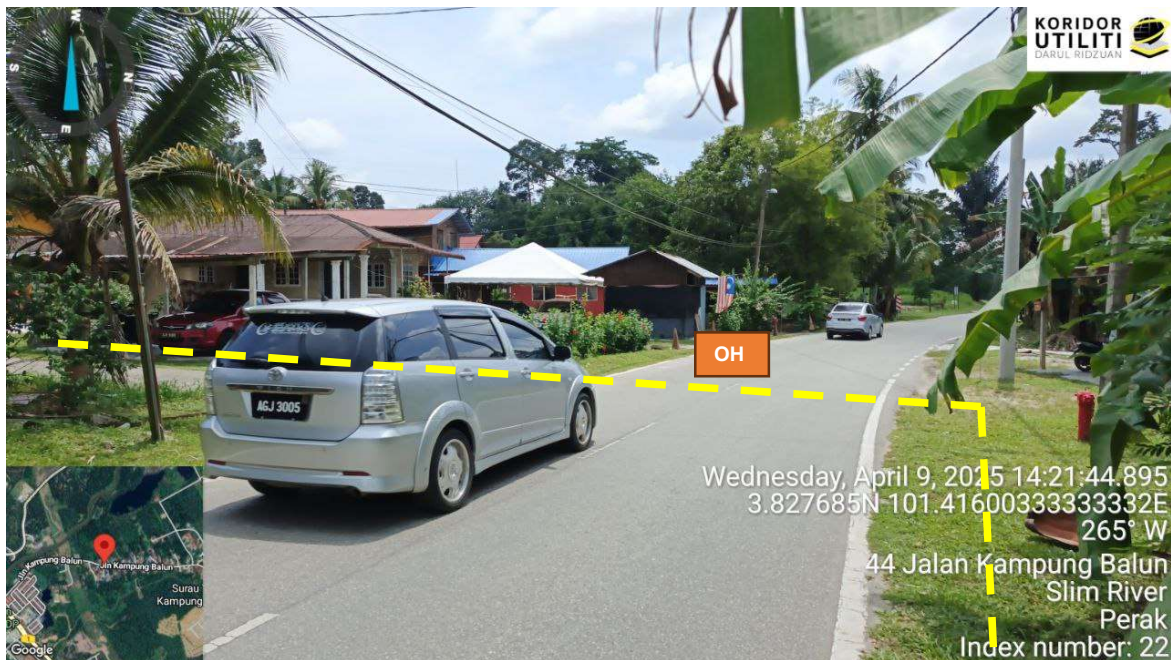
Rajah 14: Crossing Jalan Kampung Balun
