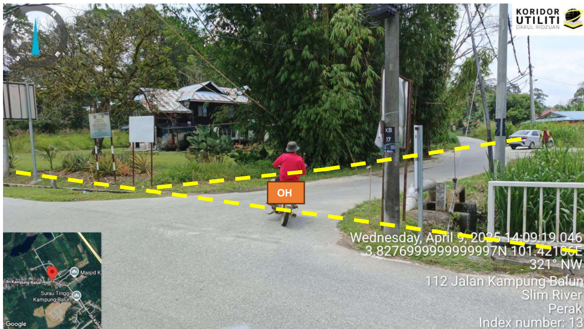
Rajah 8: Crossing Jalan Kampung Balun 2
