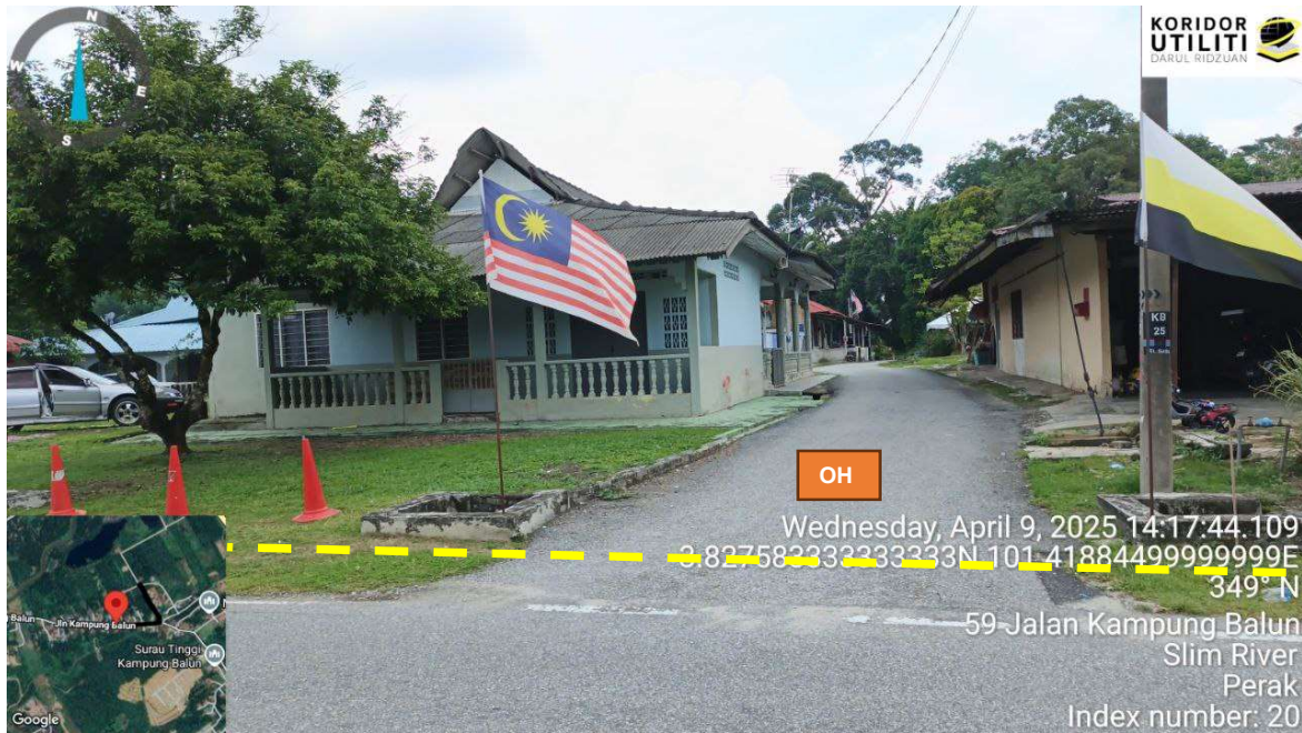
Rajah 13: Crossing Jalan Kampung Balun 3
