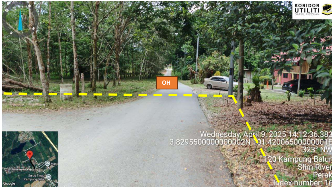
Rajah 11: Crossing Jalan Kampung Balun 2
