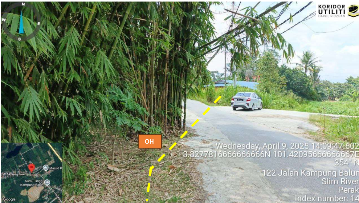
Rajah 9: Crossing Jalan Kampung Balun 2
