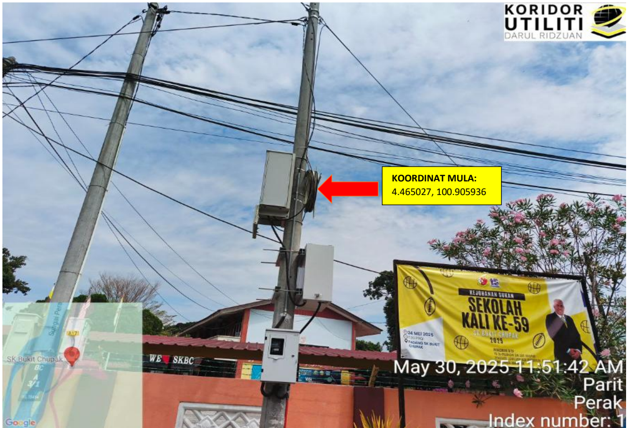
JALAN PARIT – BOTA KANAN (A017)
