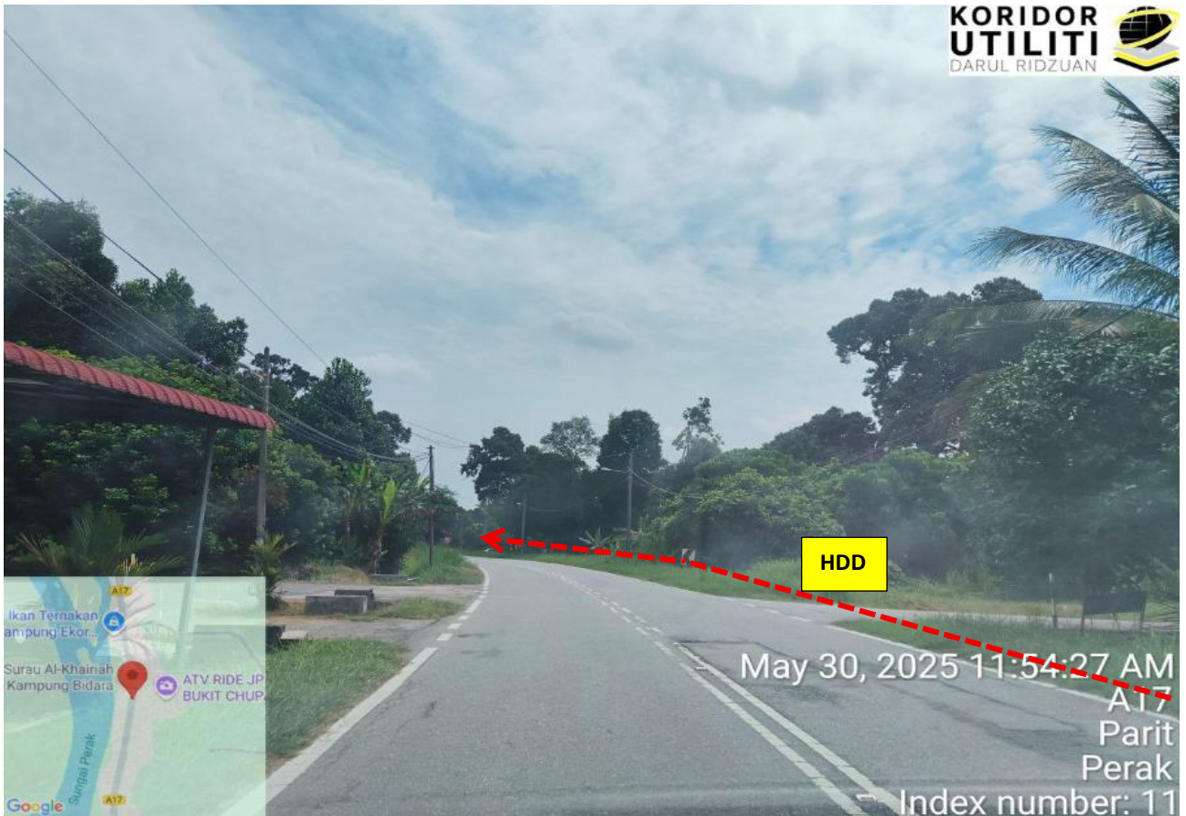
JALAN PARIT – BOTA KANAN (A017)
