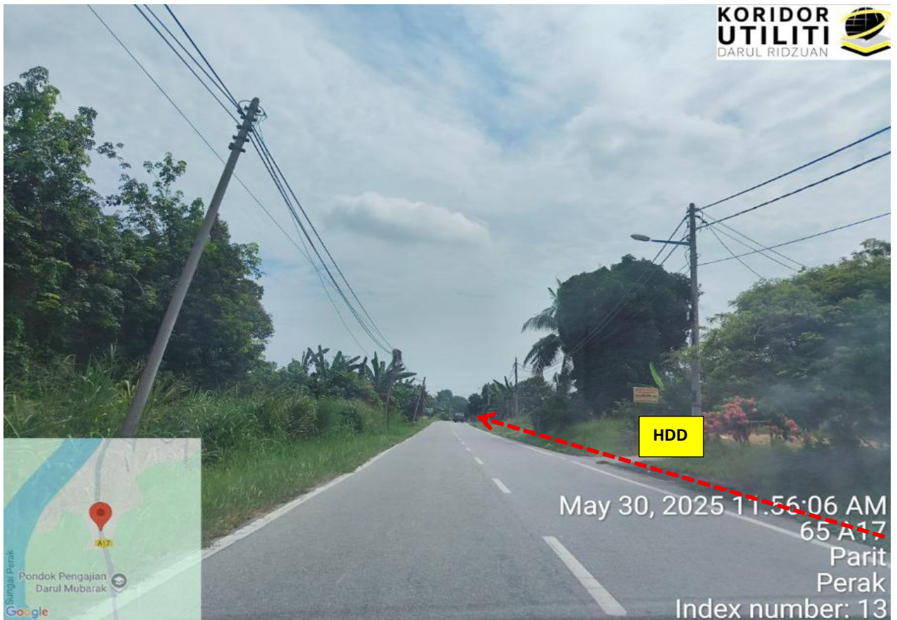
JALAN PARIT – BOTA KANAN (A017)
