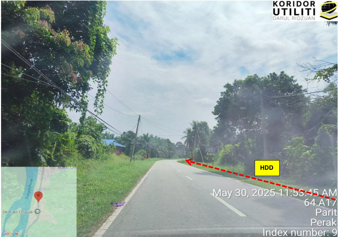
JALAN PARIT – BOTA KANAN (A017)
