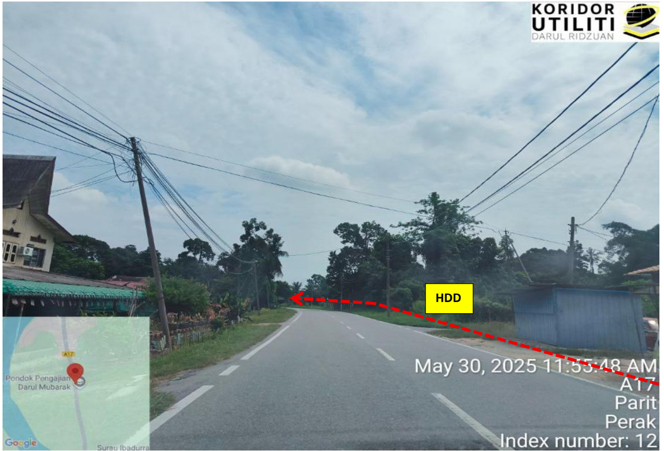
JALAN PARIT – BOTA KANAN (A017)
