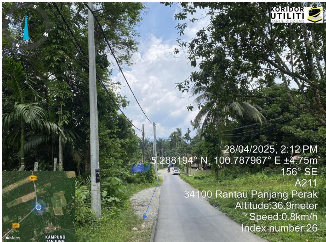
CADANGAN REPAIR LALUAN UNTUK MANHOLE SEDIADA
