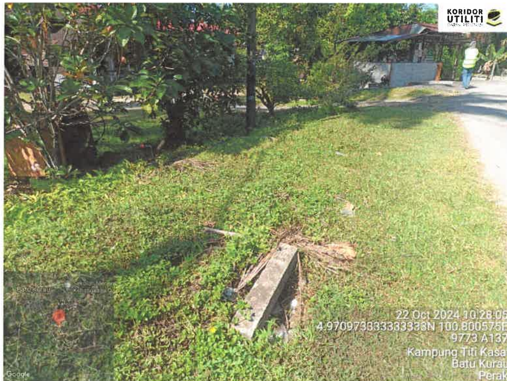
LOKASI – OPEN CUT GV DI JALAN LAMA KAMPUNG PERAK BATU KURAU
