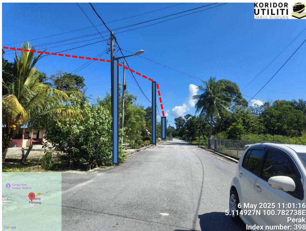
PENANAMAN TIANG DI JALAN MD SELAMA
