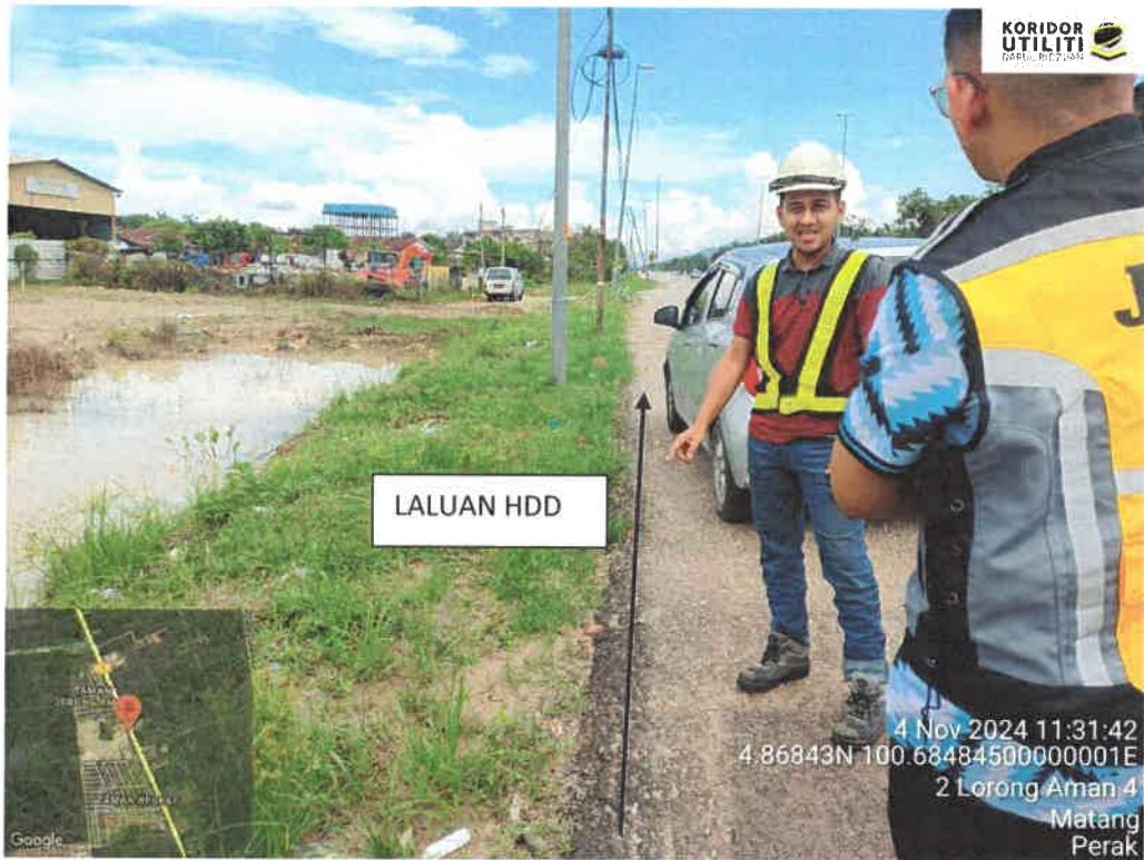
LALUAN HDD - JALAN KAMPUNG DEW
