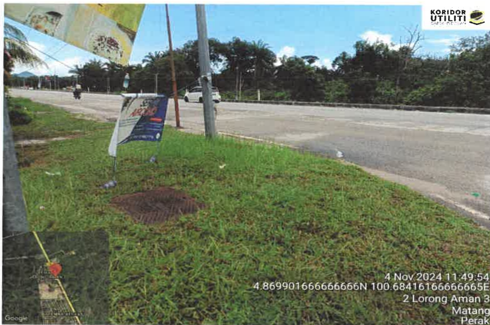
LALUAN HDD - JALAN KAMPUNG DEW
