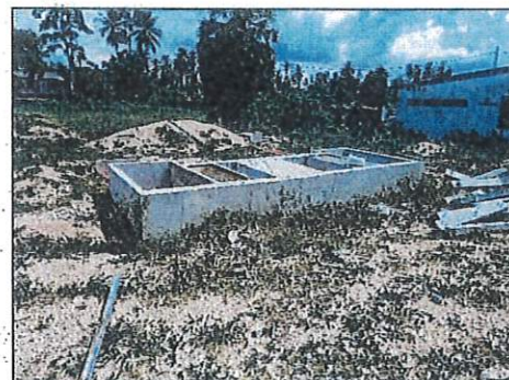
TAPAK PENCAWANG ELEKTRIK.
