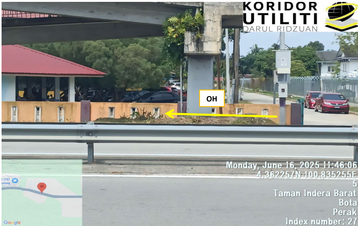
LOKASI KERJA DI LEBUHRAYA IPOH – LUMUT
