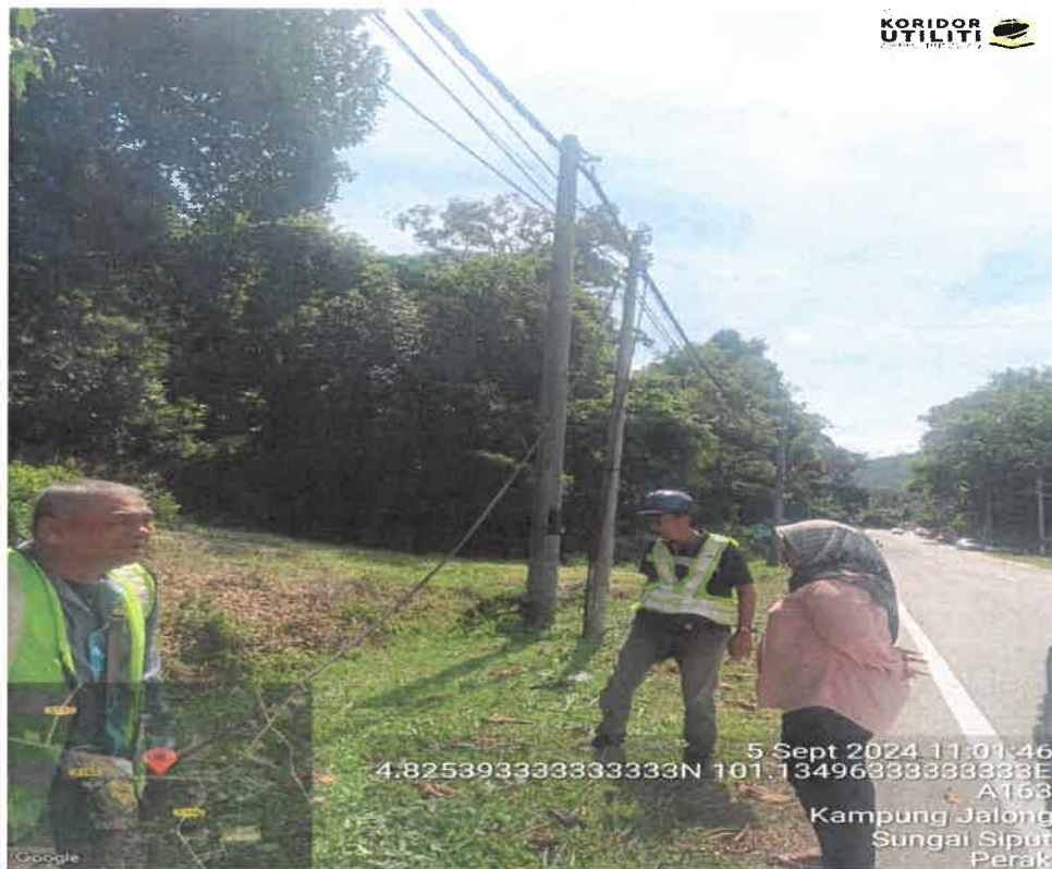
KABEL DARI OH TURUN KE HDD – JALAN KAMPUNG JALONG SUNGAI SIPUT
