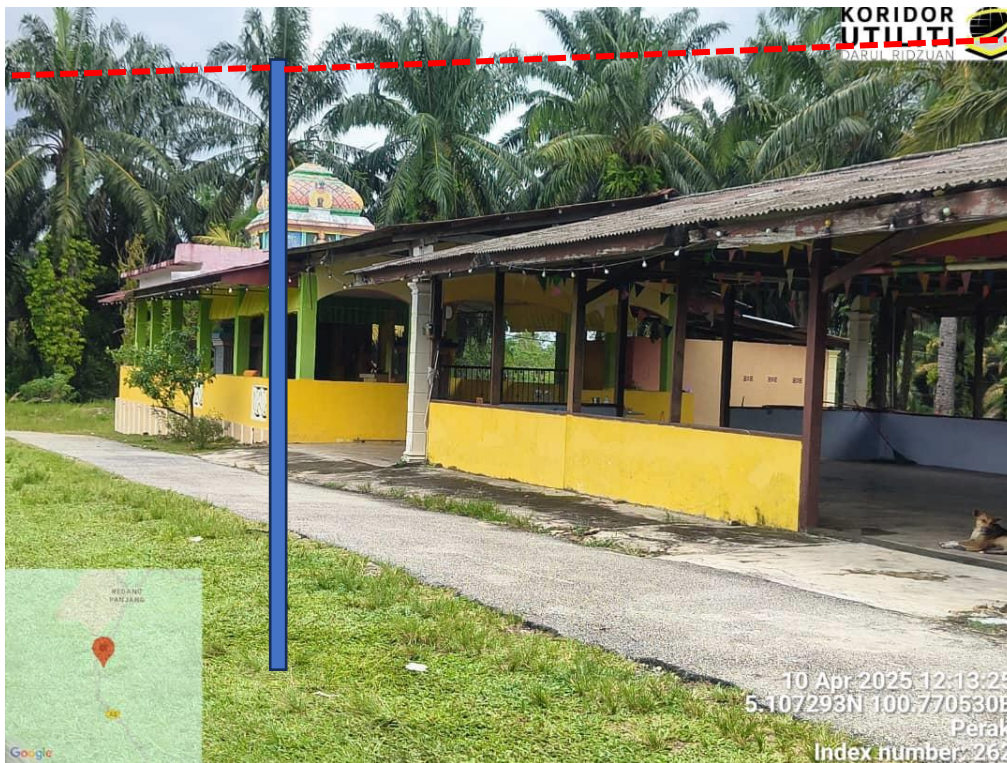
CADANGAN PENANAMAN TIANG DI JALAN PDT
