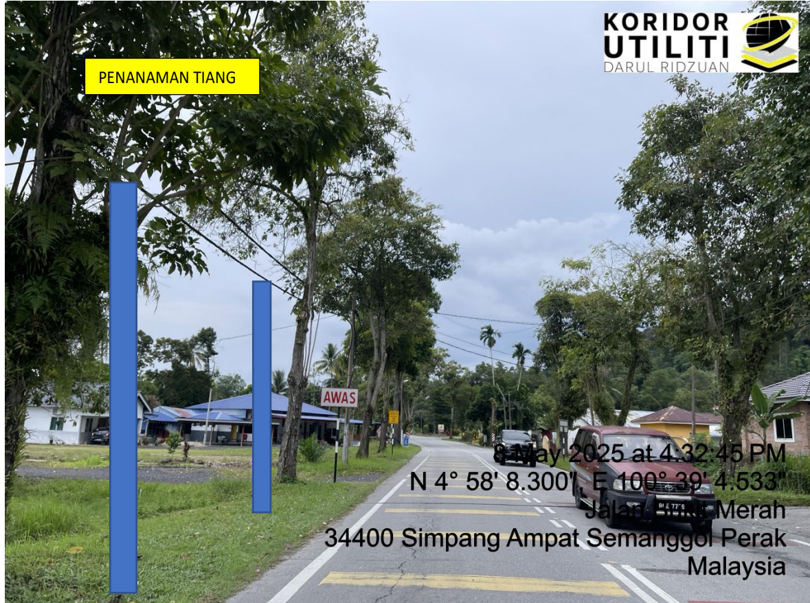
LOKASI DI JALAN SEMANGGOL – CHANGKAT LOBAK
