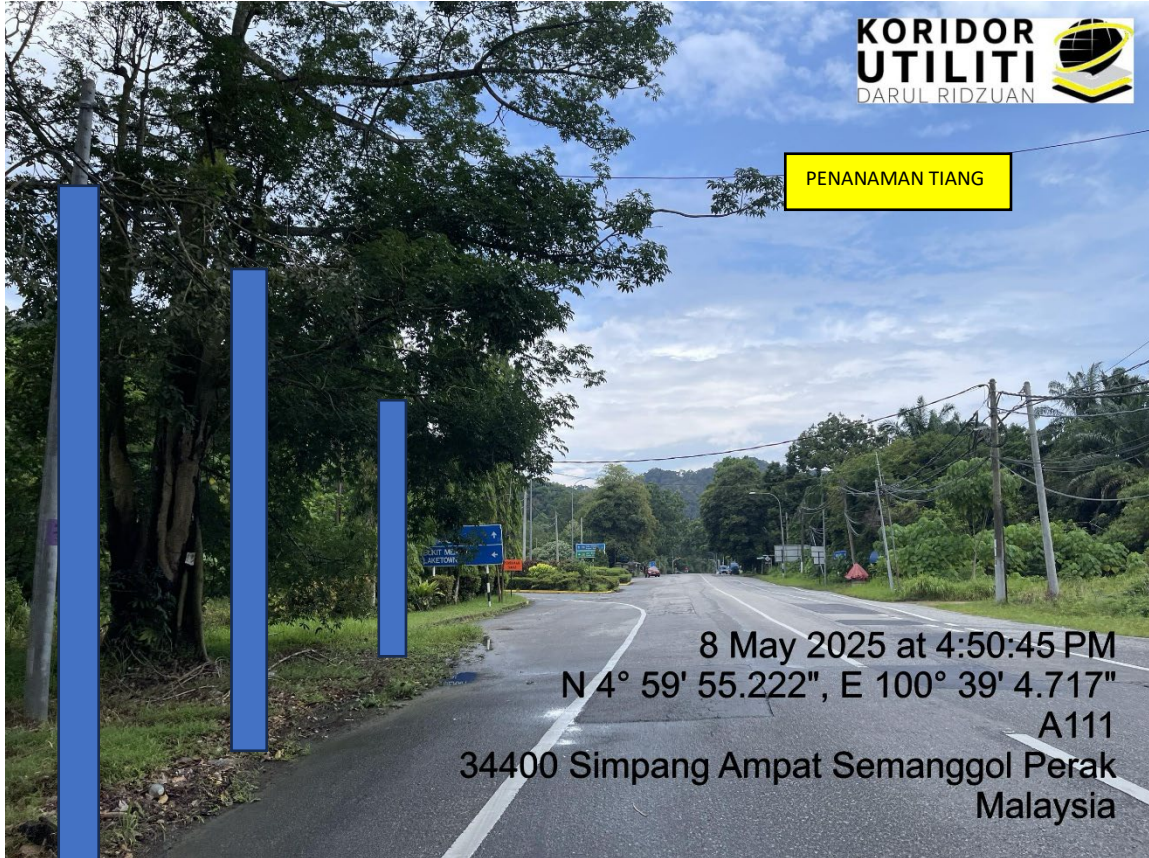
LOKASI DI JALAN SEMANGGOL – CHANGKAT LOBAK
