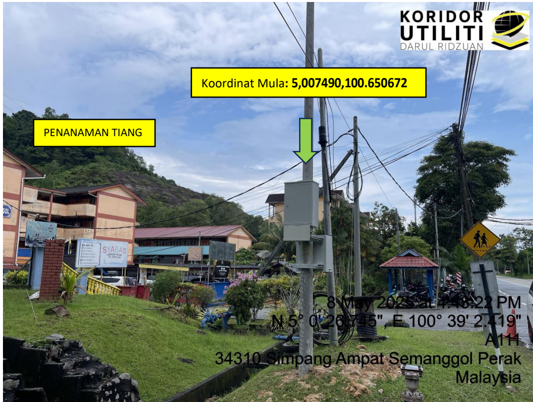
LOKASI DI JALAN SEMANGGOL – CHANGKAT LOBAK
