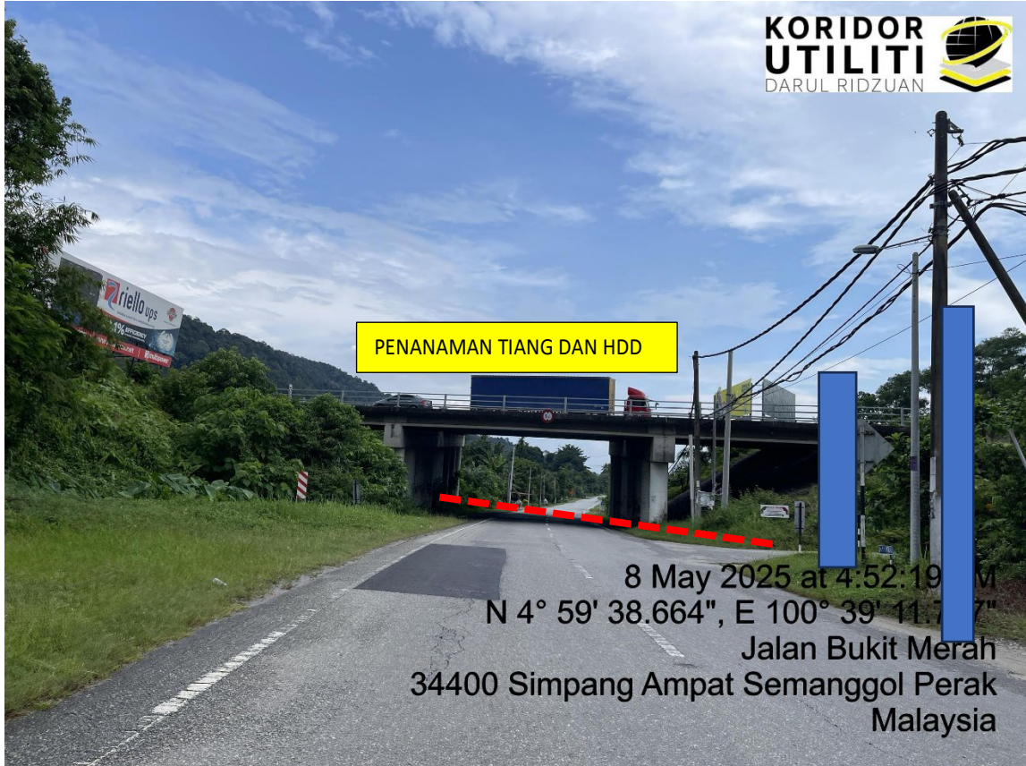
LOKASI DI JALAN SEMANGGOL – CHANGKAT LOBAK
