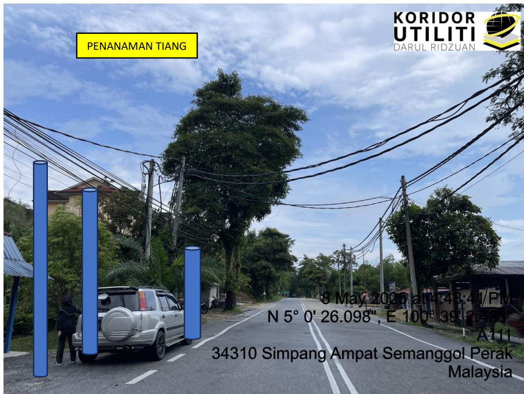
LOKASI DI JALAN SEMANGGOL – CHANGKAT LOBAK
