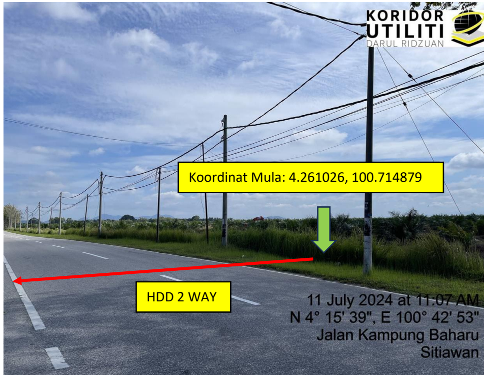
LOKASI DI A178 JALAN KAMPUNG BAHARU
