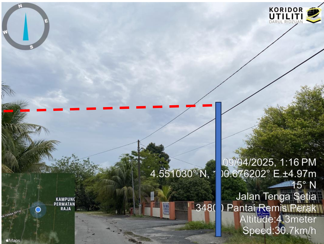
CADANGAN PENANAMAN TIANG DI JALAN PDT
