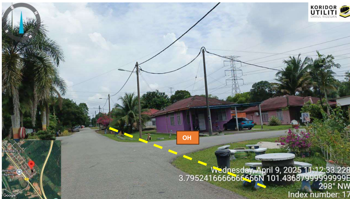
Rajah 10: Lintasan Jalan Blok 3
