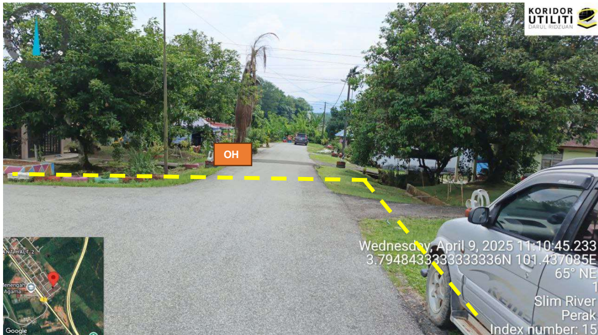
Rajah 8: Lintasan Jalan Blok 3
