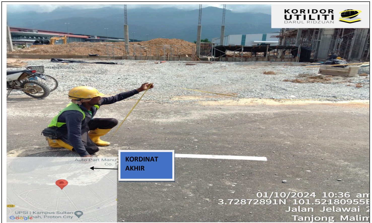
KORDINAT AKHIR: 3.728582, 101.52189 LOKASI:JALAN JELAWAI
