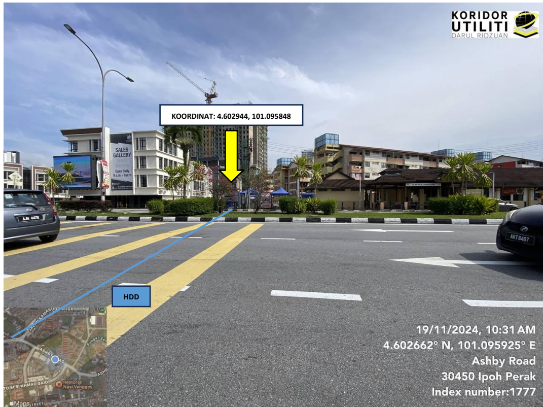
LOKASI KOREKAN HDD DI JALAN DATO' SERI AHMAD SAID (HDD CROSSING)
