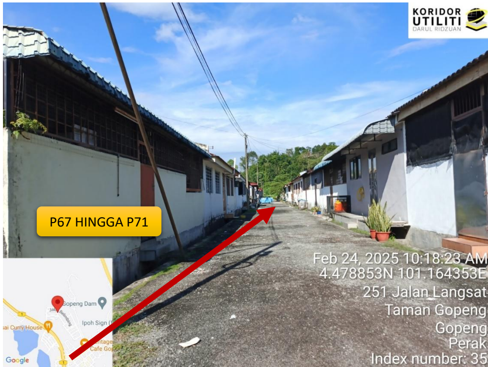
PEMASANGAN TIANG MENGIKUTI JAJARAN TIANG TNB SEDIA ADA DI BELAKANG JALAN LANGSAT DAN BELIMBING
