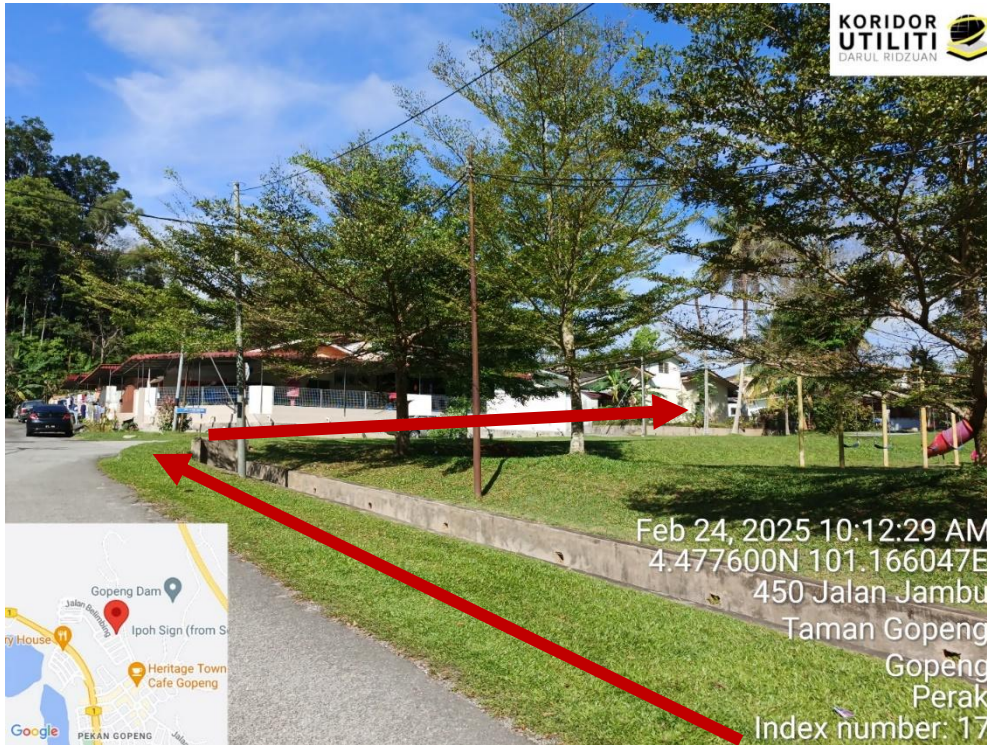
PEMASANGAN TIANG MENGIKUTI JAJARAN TIANG TNB SEDIA ADA
