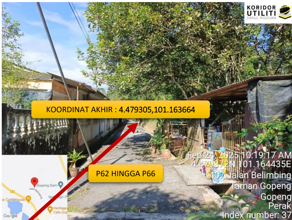
PEMASANGAN TIANG MENGIKUTI JAJARAN TIANG TNB SEDIA ADA DI BELAKANG RUMAH JALAN BELIMBING
