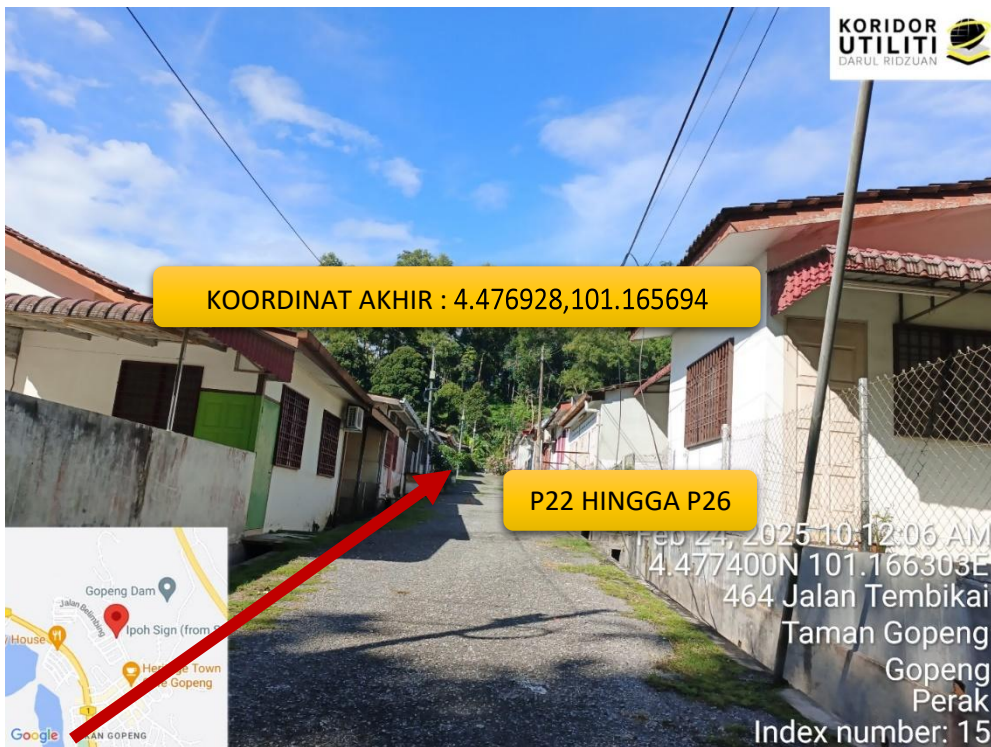
PEMASANGAN TIANG MENGIKUTI JAJARAN TIANG TNB SEDIA ADA DIBELAKANG RUMAH PADA JALAN TEMBIKAI DAN JALAN JAMBU
