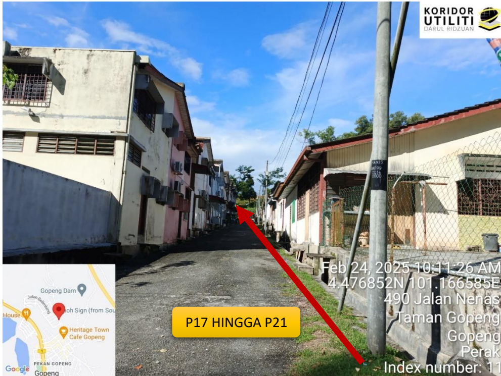
PEMASANGAN TIANG MENGIKUTI JAJARAN TIANG TNB SEDIA ADA DIBELAKANG RUMAH PADA JALAN NENAS DAN JALAN TEMBIKAI
