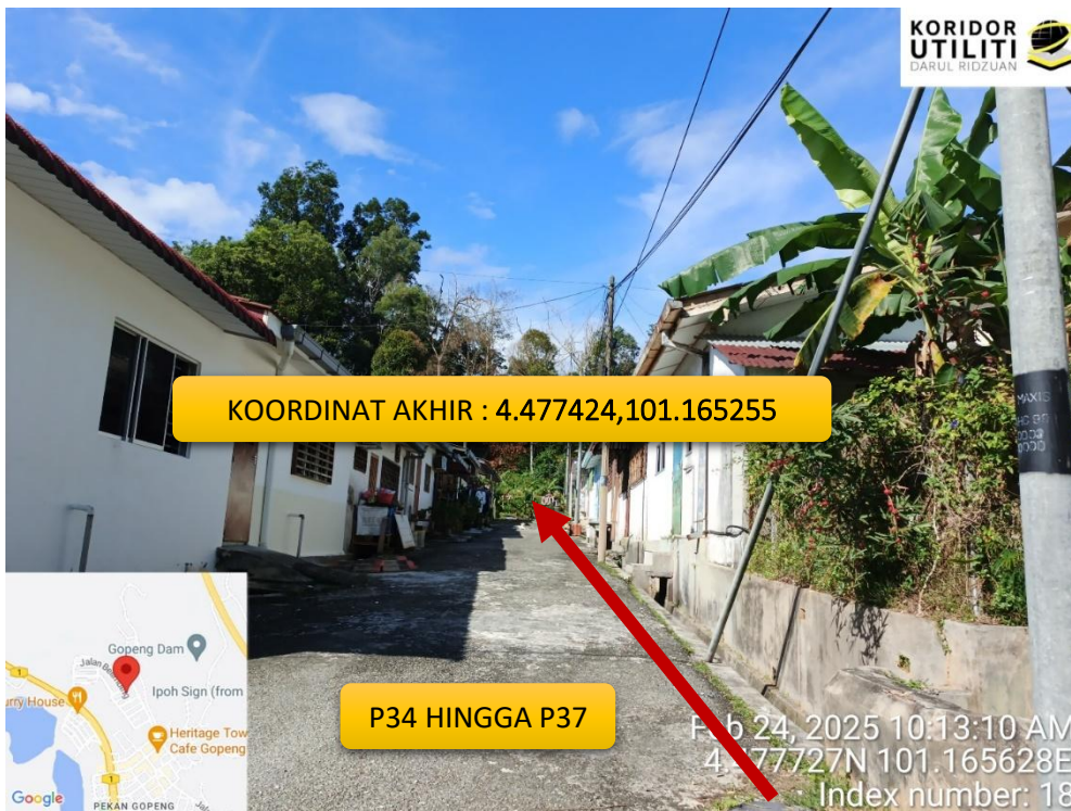
PEMASANGAN TIANG MENGIKUTI JAJARAN TIANG TNB SEDIA ADA DIBELAKANG RUMAH PADA JALAN CEMPEDAK DAN JALAN JAMBU
