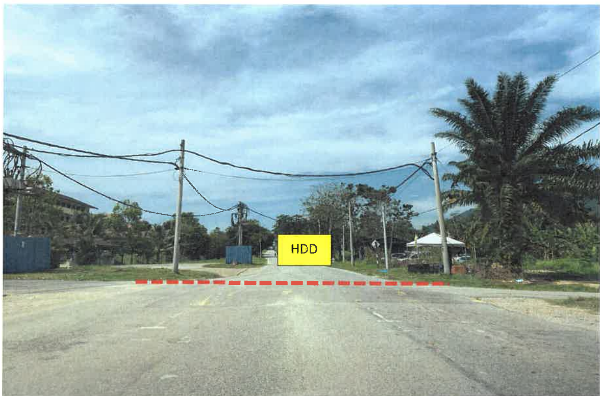
JALAN A19 (BERHADAPAN SMK BAWONG)
