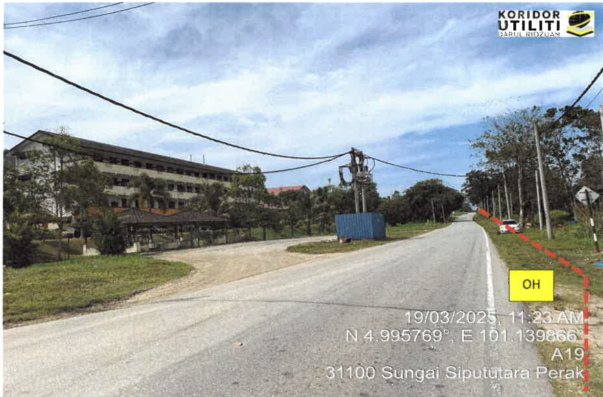
JALAN A19 (BERHADAPAN SMK BAWONG)
