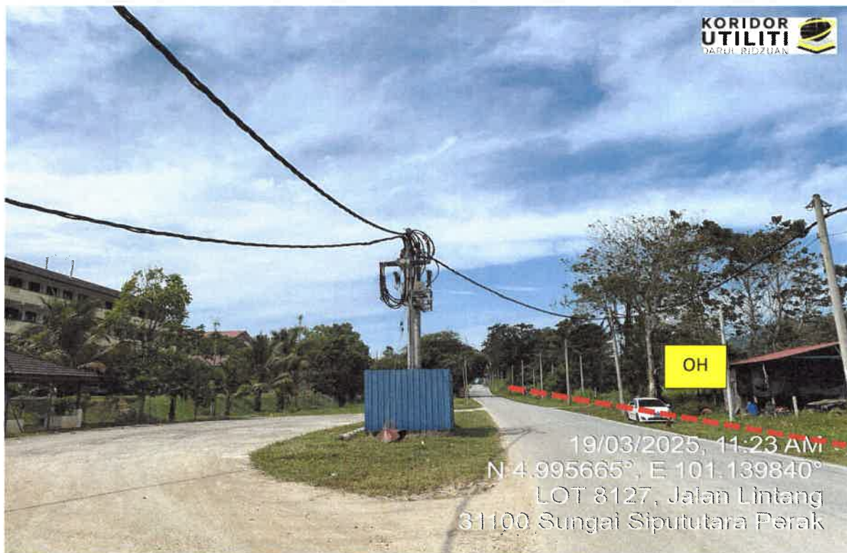
JALAN A19 (BERHADAPAN SMK BAWONG)
