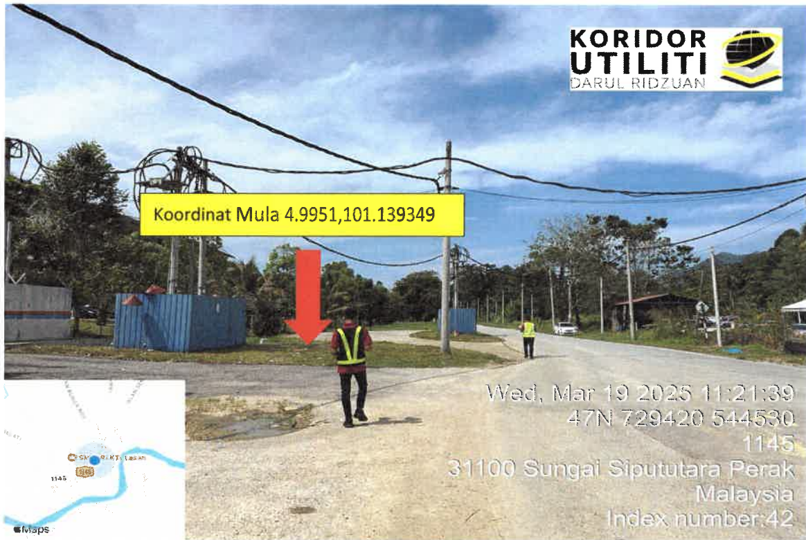
JALAN A19 (BERHADAPAN SMK BAWONG)
