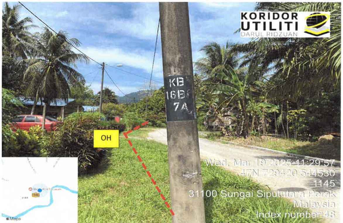
JALAN KAMPUNG BAWONG
