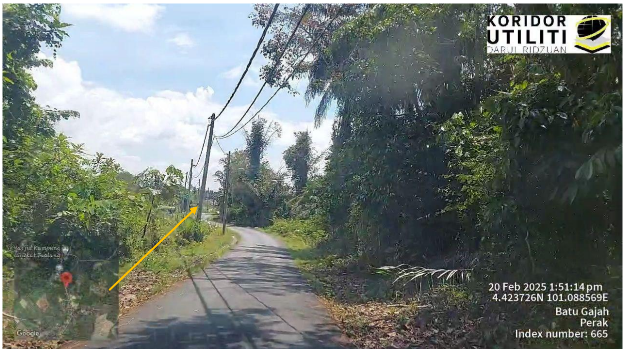
PEMASANGAN TIANG MENGIKUT JAJARAN TIANG TNB SEDIA ADA
