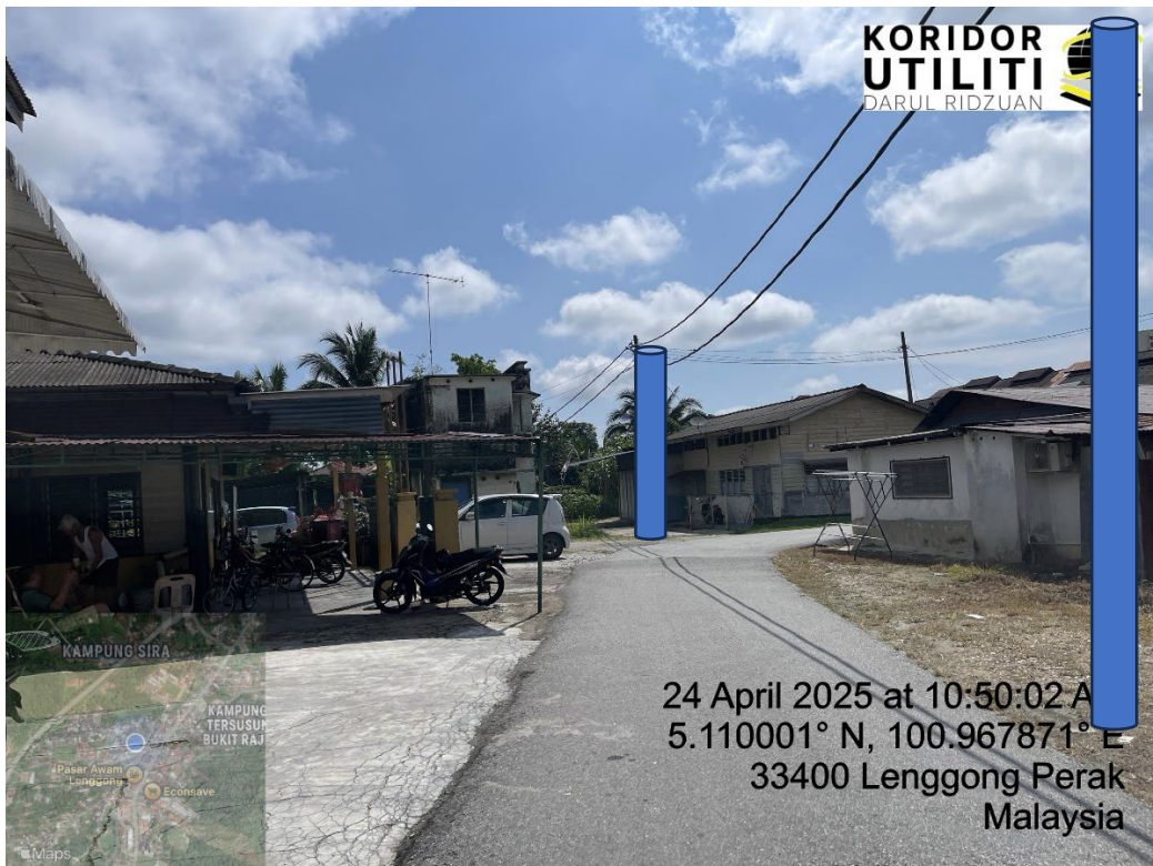
LOKASI DI JALAN BUKIT BALAI
