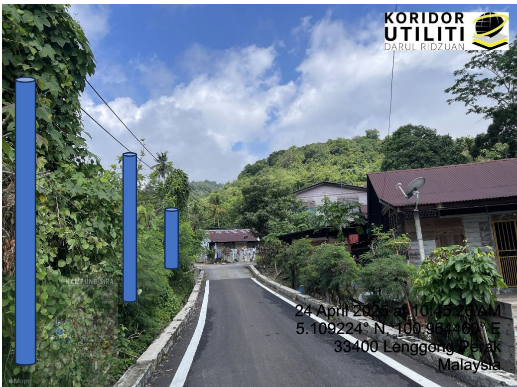
LOKASI DI JALAN BUKIT BALAI
