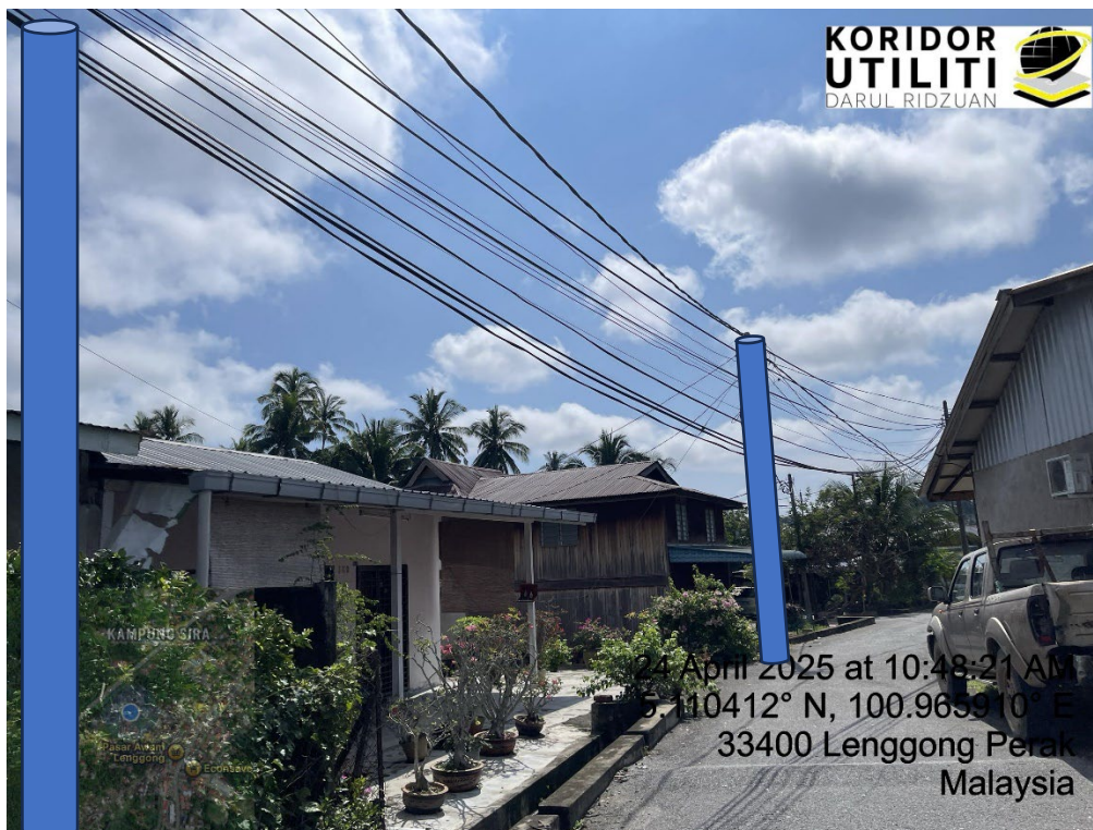
LOKASI DI JALAN BUKIT BALAI
