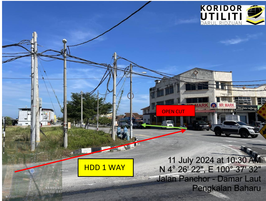
LOKASI DI PERSIMPANGAN JALAN PERSIARAN PANTAI BARU
