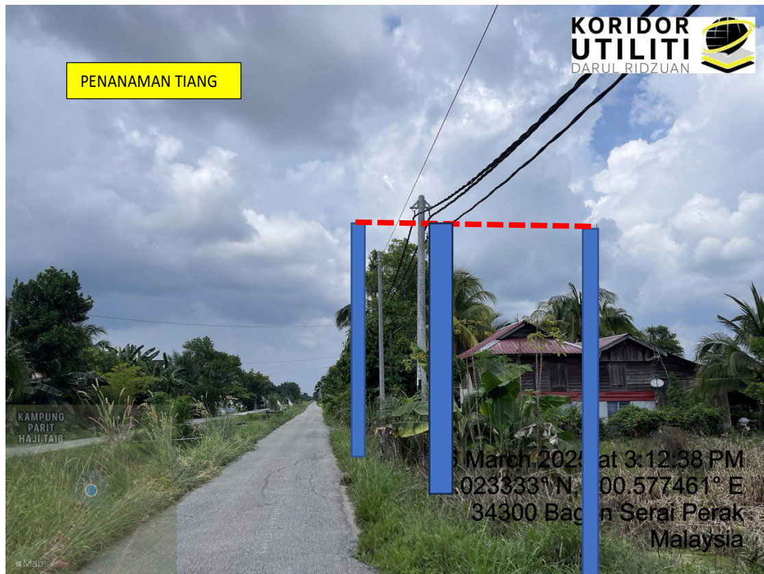
LOKASI DI JALAN KAMPUNG PARIT HAJI TAIB 3
