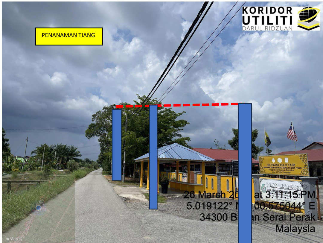
LOKASI DI JALAN KAMPUNG PARIT HAJI TAIB 3
