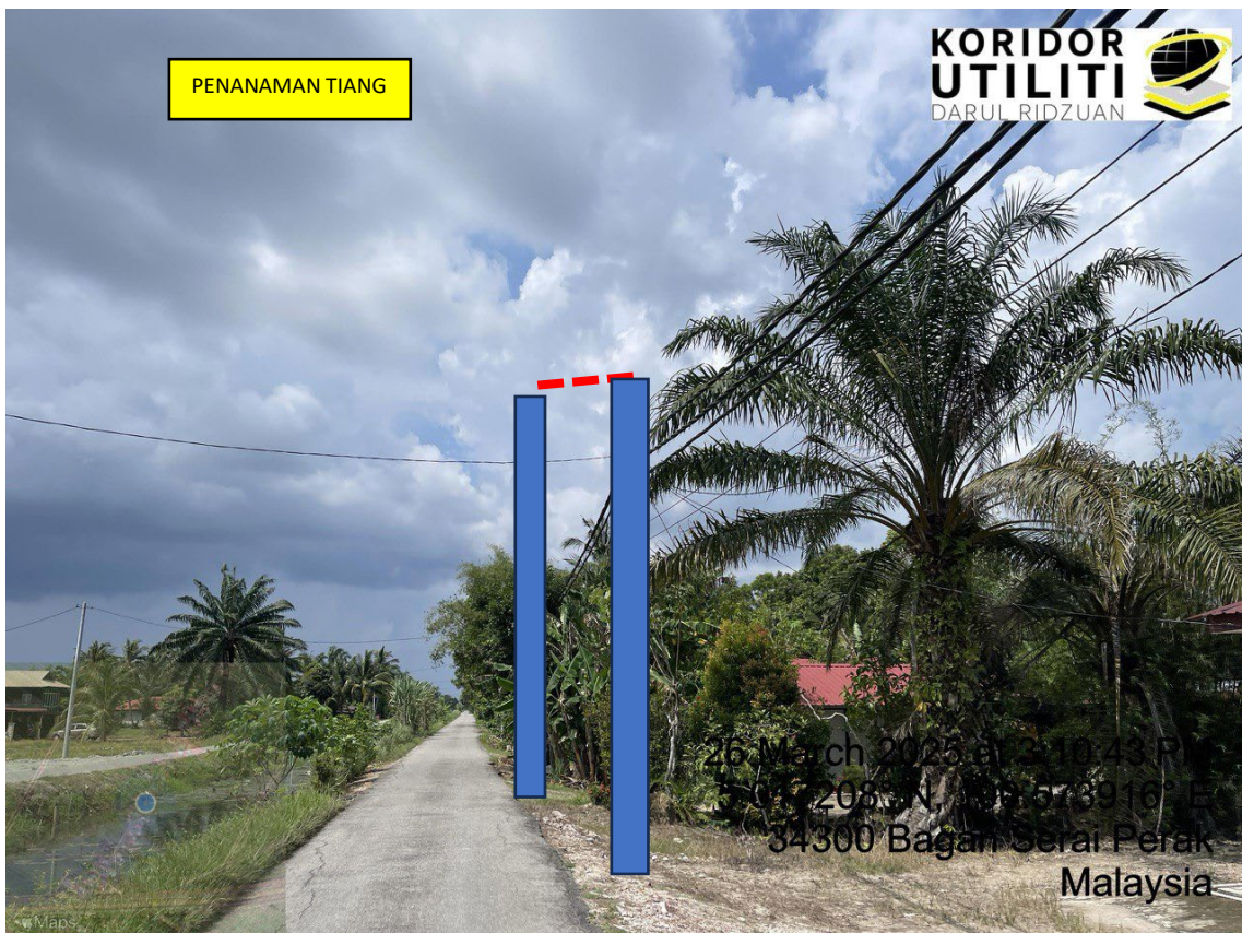
LOKASI DI JALAN KAMPUNG PARIT HAJI TAIB 3
