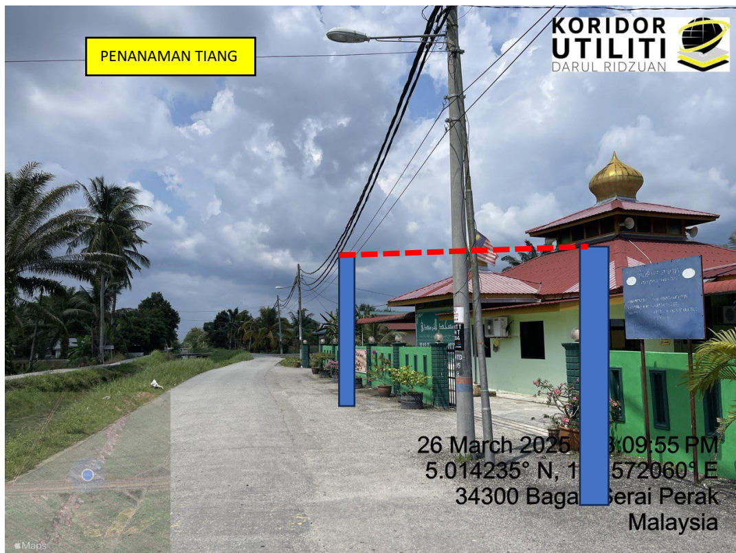
LOKASI DI JALAN KAMPUNG PARIT HAJI TAIB 3
