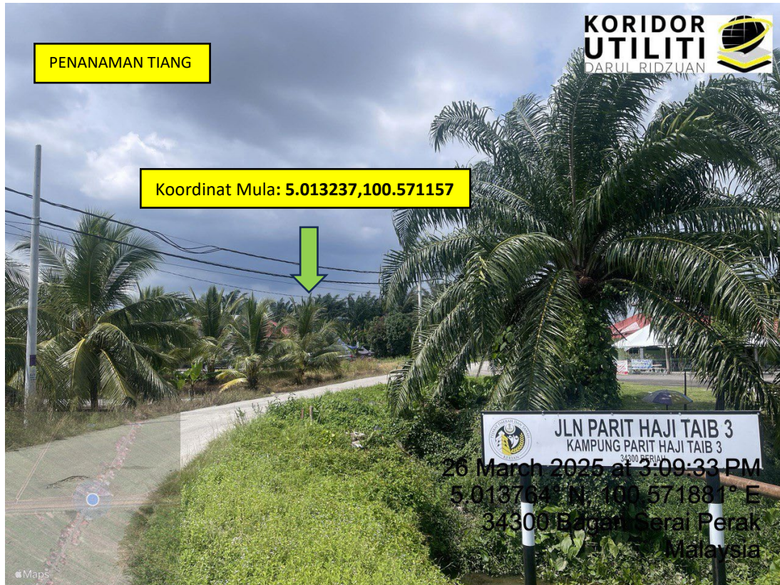
LOKASI DI JALAN KAMPUNG PARIT HAJI TAIB 3
