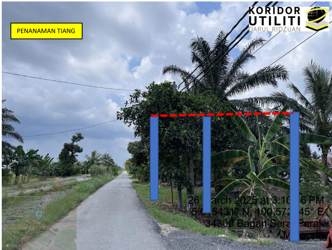
LOKASI DI JALAN KAMPUNG PARIT HAJI TAIB 3
