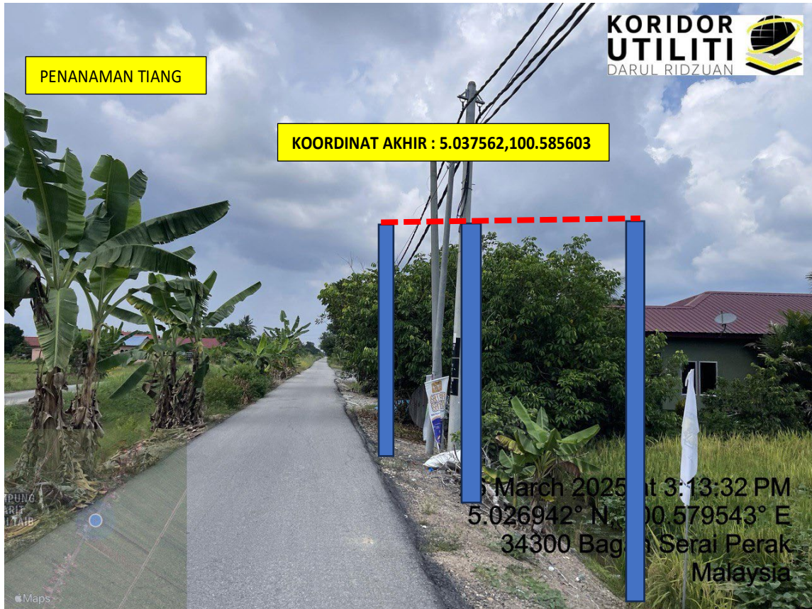
LOKASI DI JALAN KAMPUNG PARIT HAJI TAIB 3
