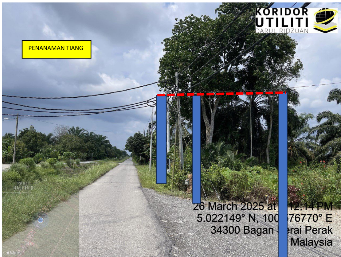
LOKASI DI JALAN KAMPUNG PARIT HAJI TAIB 3
