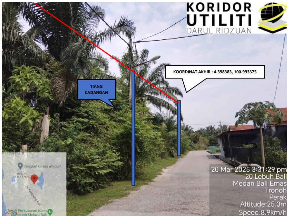
JAJARAN PENANAMAN TIANG DI HALA BALI 8
