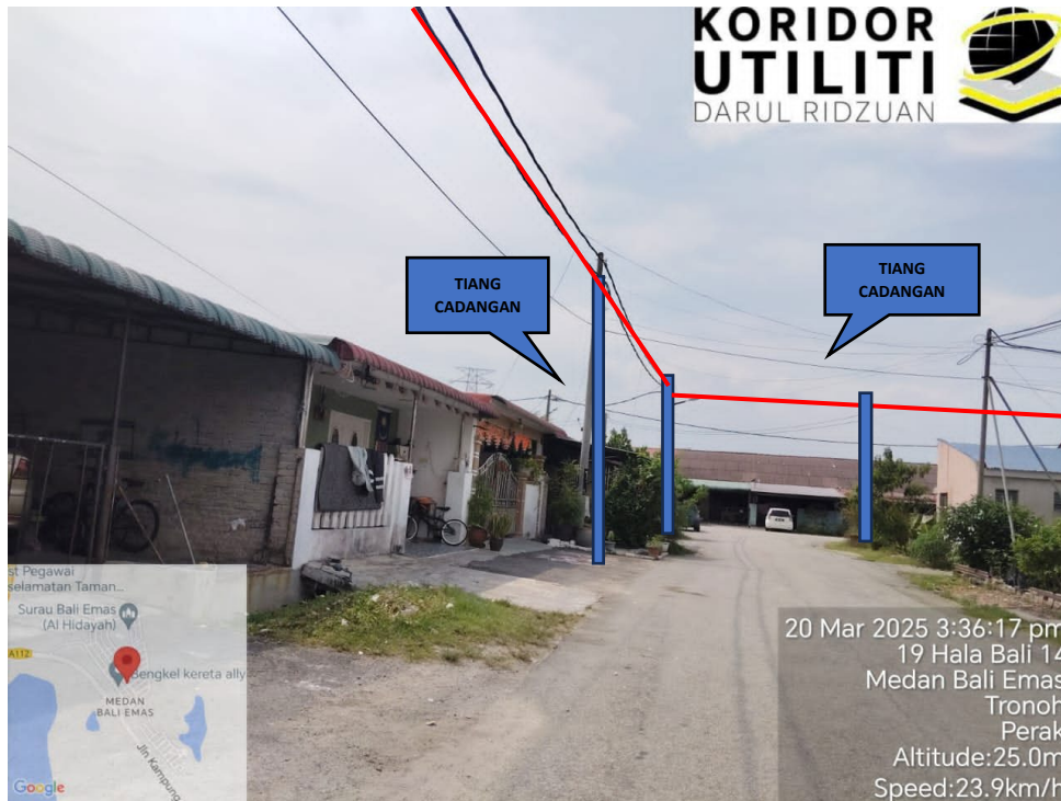
JAJARAN PENANAMAN TIANG DI HALA BALI 14
