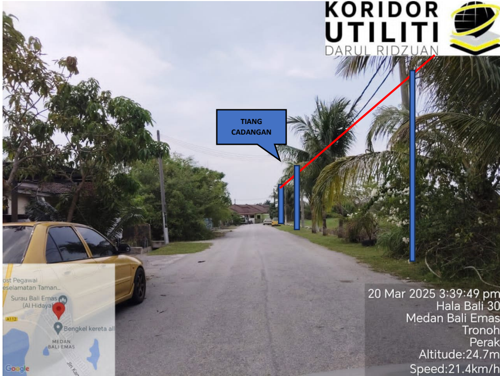
JAJARAN PENANAMAN TIANG DI HALA BALI 30
