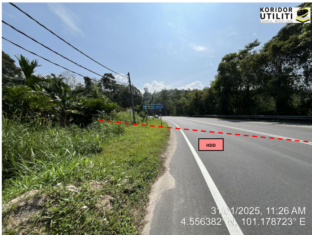
JAJARAN KOREKAN HDD BERDEKATAN P/E KPG. JUANG MELINTASI JALAN SIMPANG PULAI – BLUE VALLEY (FT185)
