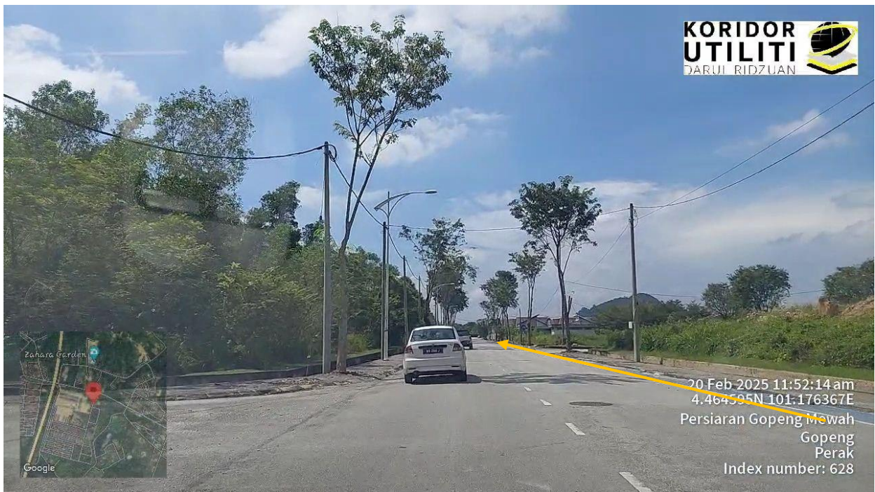
CADANGAN PEMASANGAN TIANG DI JAJARAN SEBELAH KANAN
