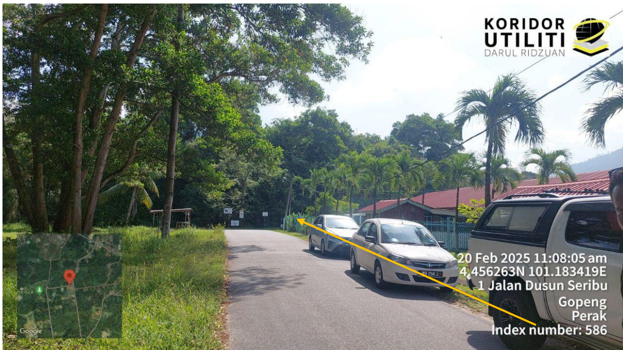
JAJARAN PEMASANGAN TIANG
