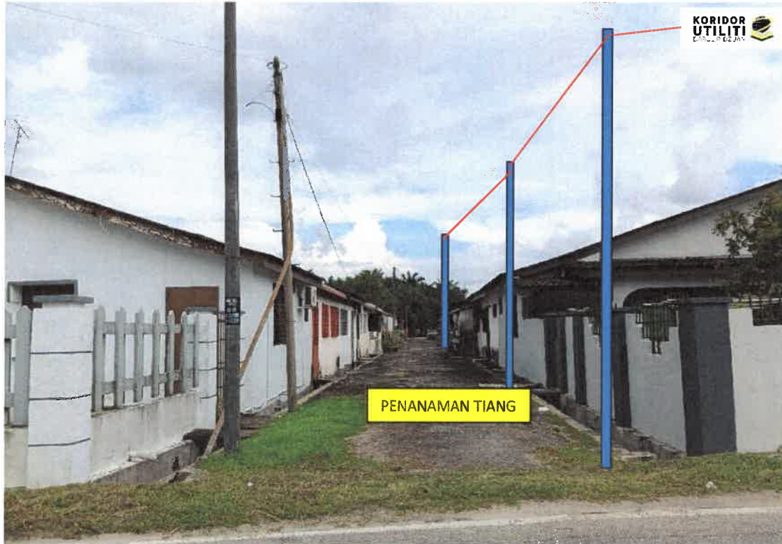
LOKASI DI LORONG BELAKANG TAMAN ANGERIK
