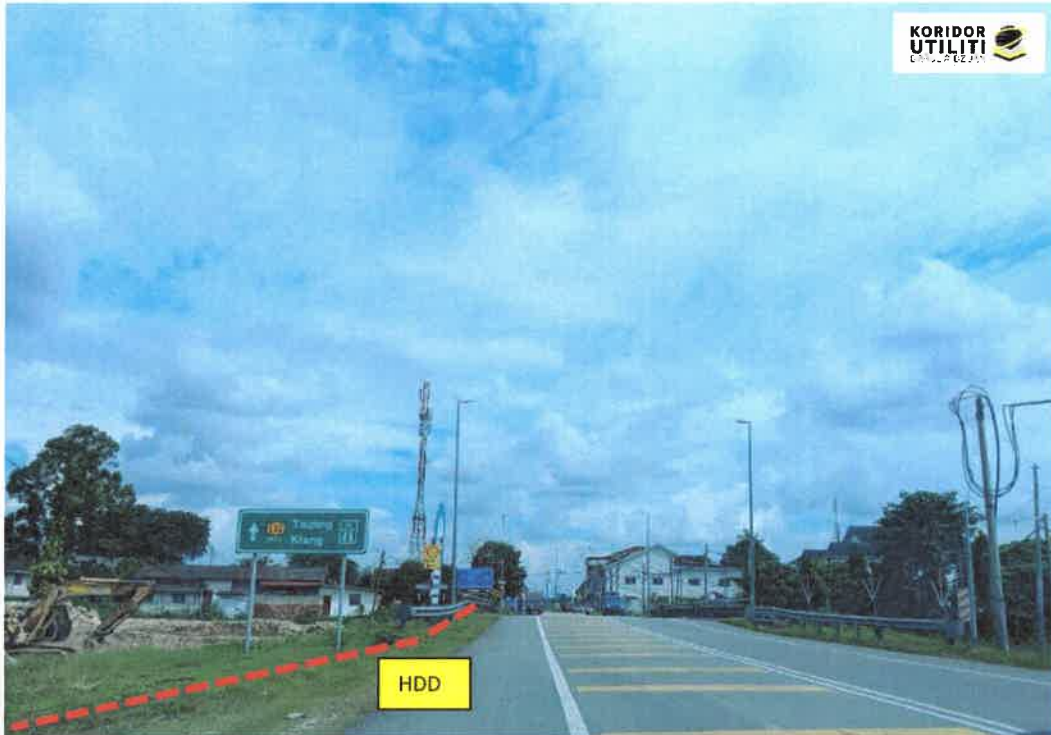
LOKASI DI JALAN SIPUTEH-BATU HAMPAR FT063
