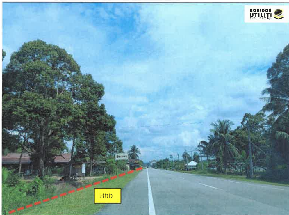
LOKASI DI JALAN SIPUTEH-BATU HAMPAR FT063
