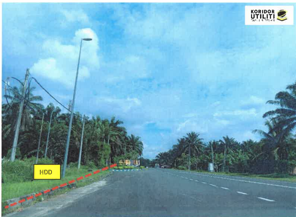
LOKASI DI JALAN SIPUTEH-BATU HAMPAR FT063
