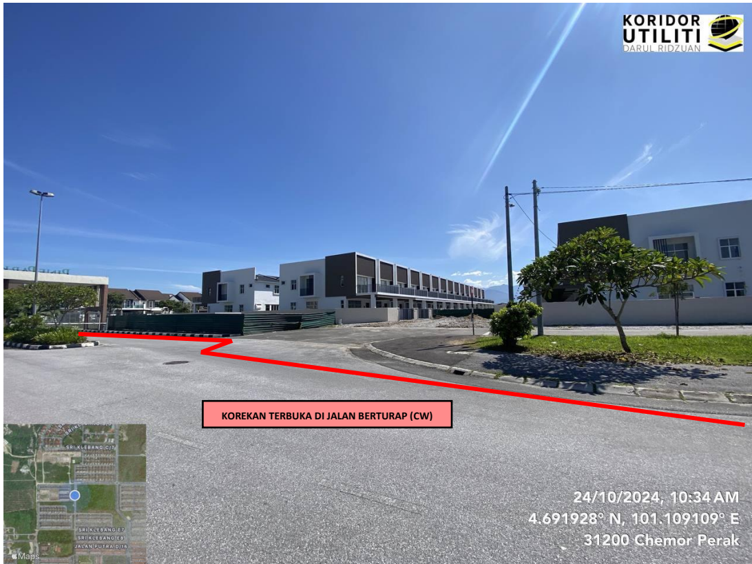
JAJARAN KOREKAN TERBUKA JALAN BERTURAP DI SRI KLEBANG E/1
