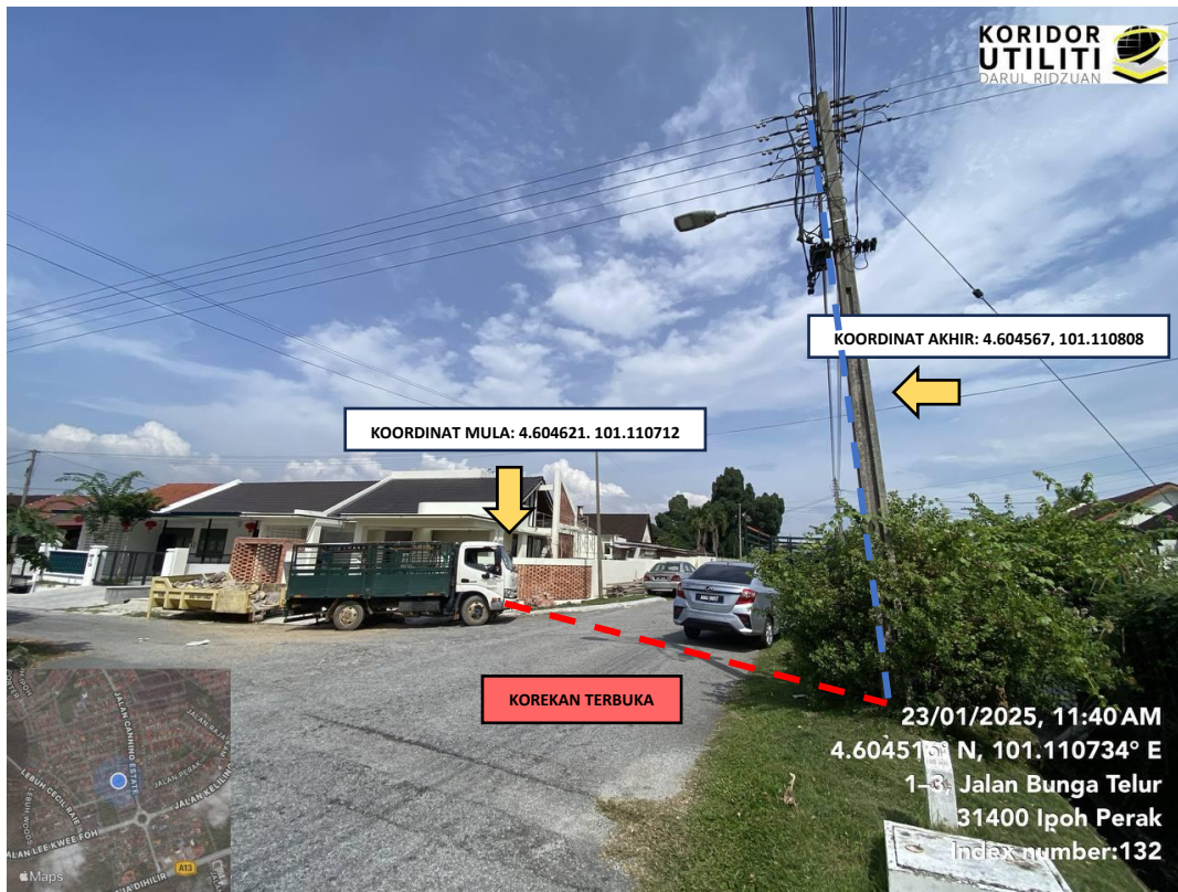
LOKASI CADANGAN KOREKAN TERBUKA DI JALAN BUNGA TELUR Sambungan akan dibuat daripada meter panel ke tiang konkrit sediaada
