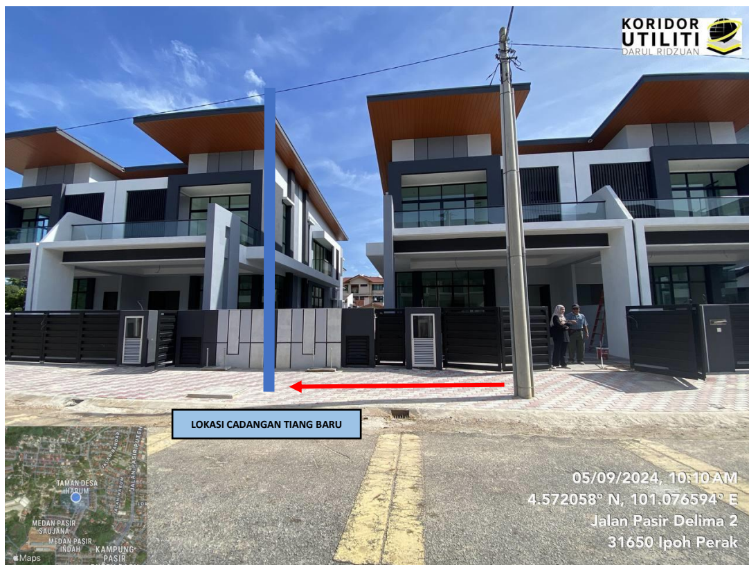
LOKASI PENGALIHAN SEBATANG TIANG DI JALAN PASIR DELIMA 2 (TIANG PERLU DIALIH \geq 3.5 METER KE KIRI)
