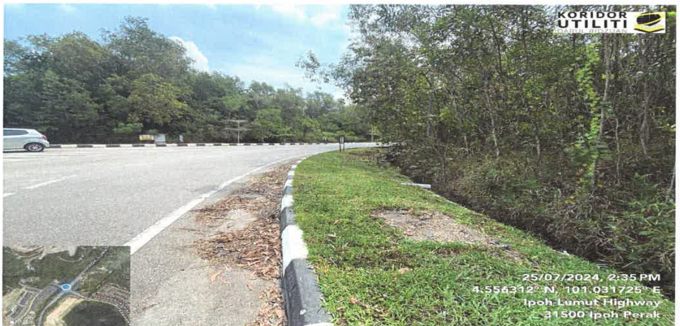
Manhole existing manhole di koordinat mula
