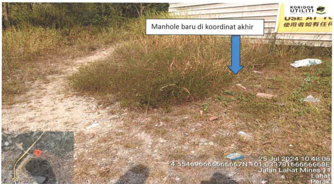
Koordinat akhir : 4.554684, 101.033762 – Lokasi manhole baru (2)
