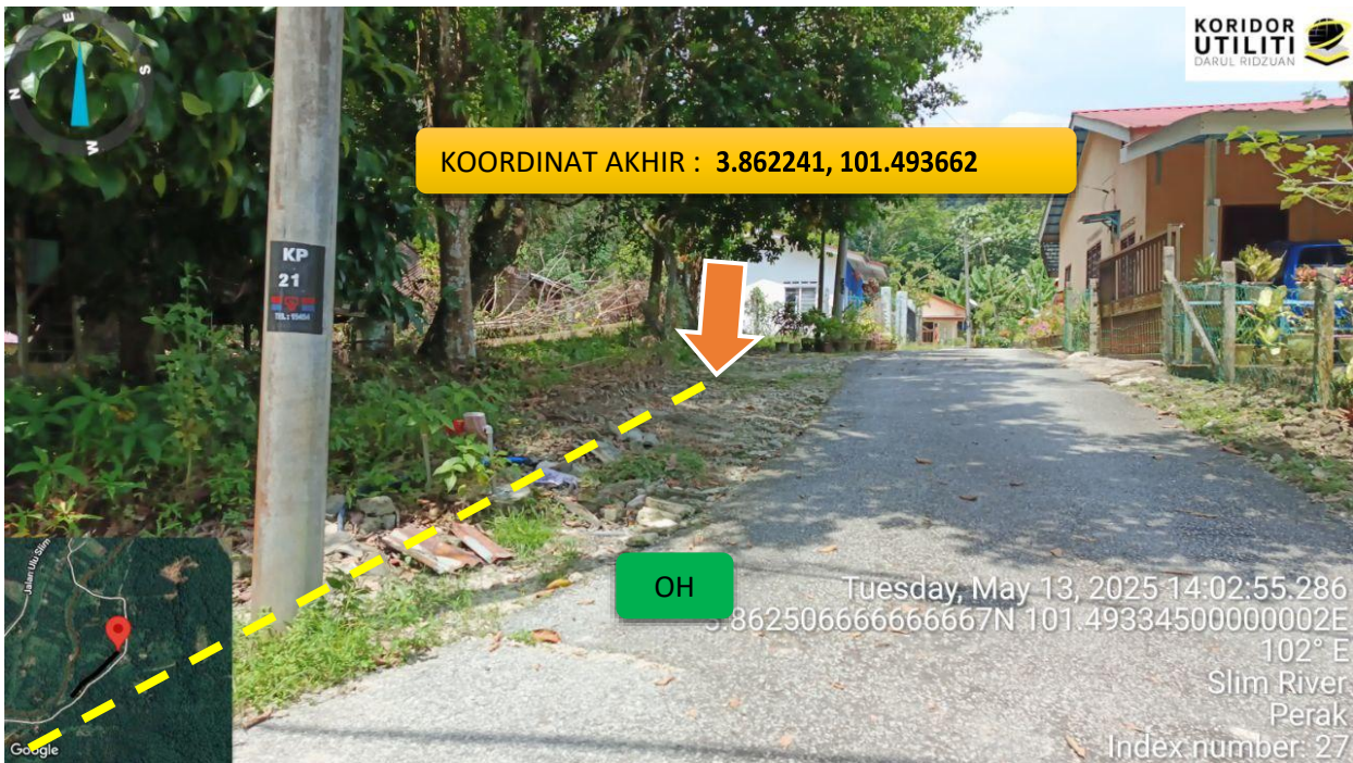
RAJAH 24 : JALAN DALAM KAMPUNG LINTAH PIONG
