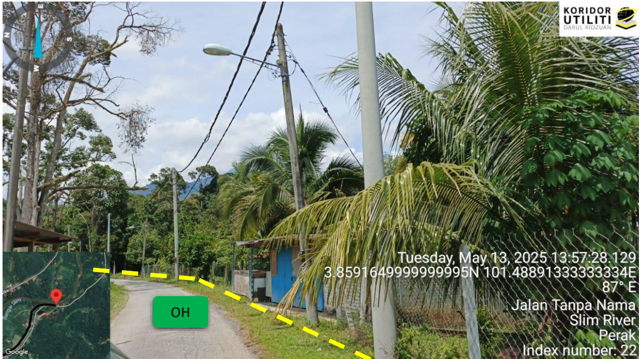
RAJAH 19 : JALAN DALAM KAMPUNG LINTAH PIONG
