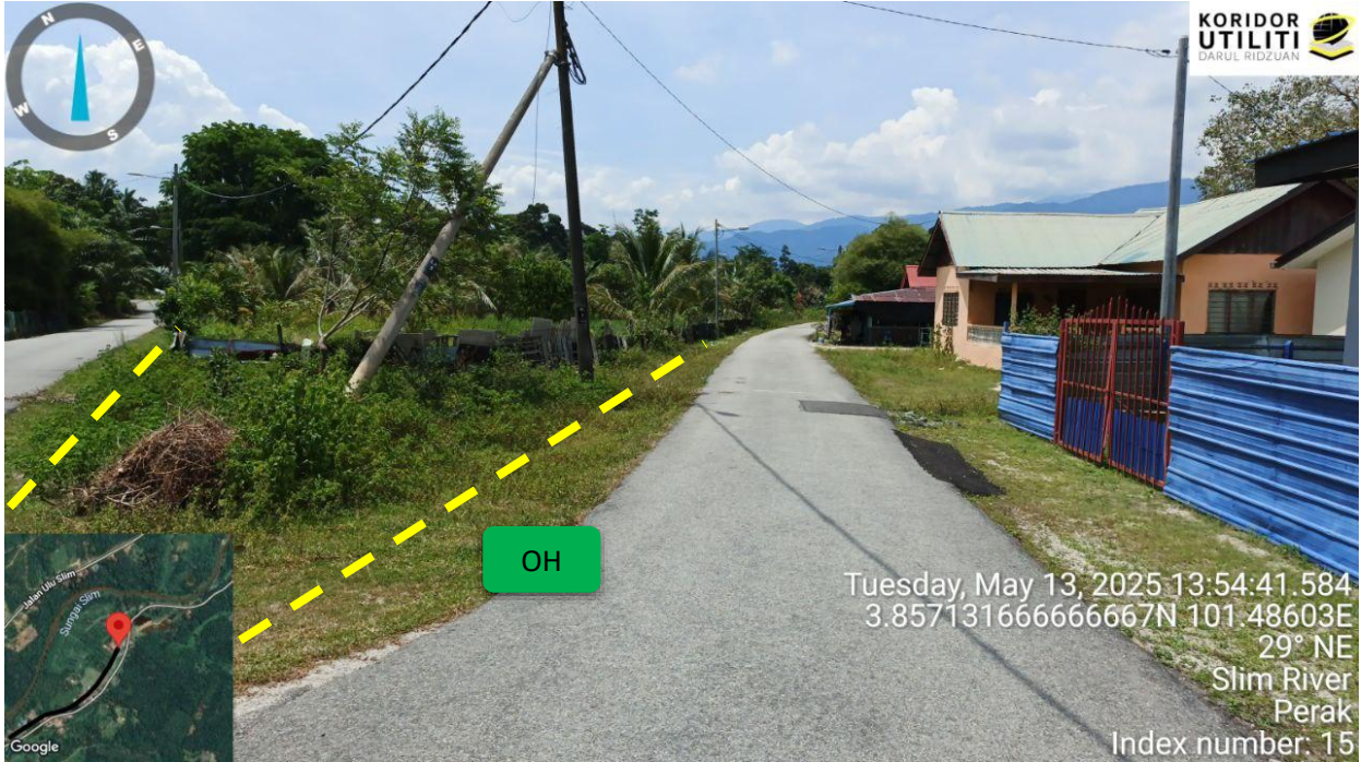
RAJAH 13 : JALAN DALAM KAMPUNG LINTAH PIONG
