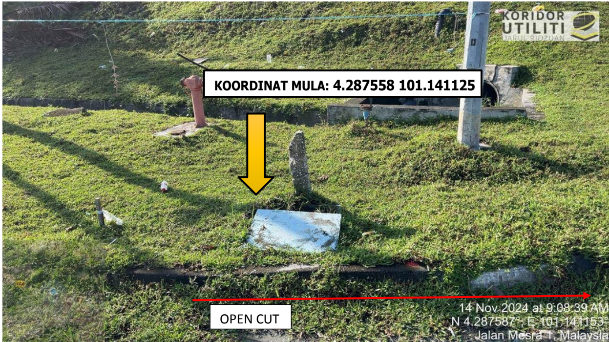
LOKASI: JALAN MESRA
