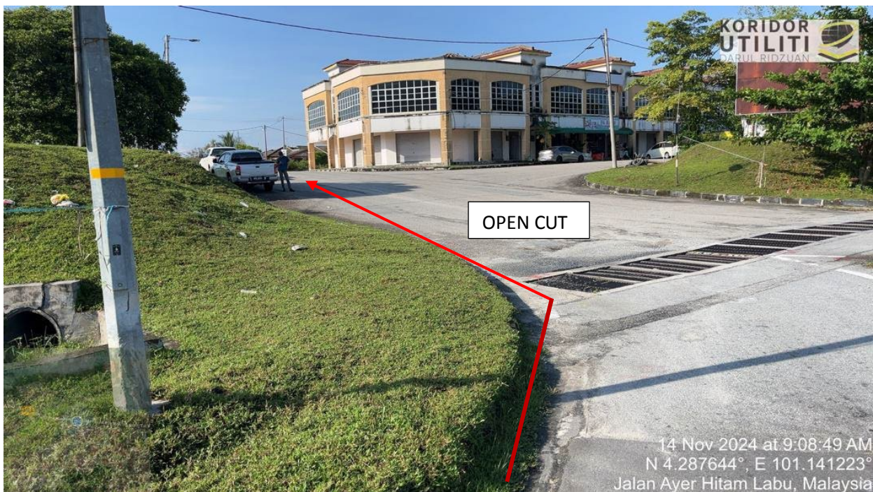
LOKASI: JALAN MESRA
