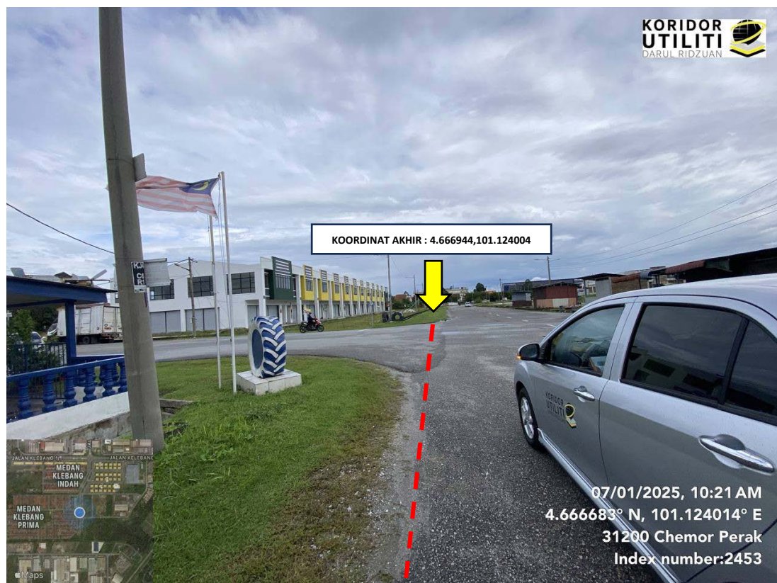
JAJARAN KAEDAH KOREKAN TERBUKA DI PERSIARAN INDUSTRI KELEBANG 1
