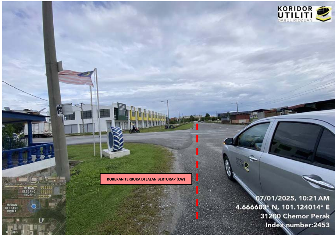
JAJARAN KAEDAH KOREKAN TERBUKA DI PERSIARAN INDUSTRI KELEBANG 1
