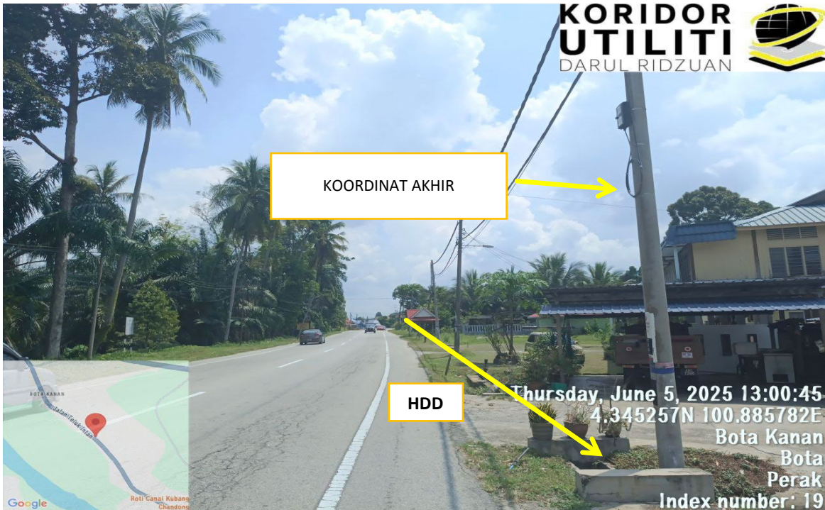
JALAN BOTA KANAN – KG GAJAH – TELUK INTAN (109)
