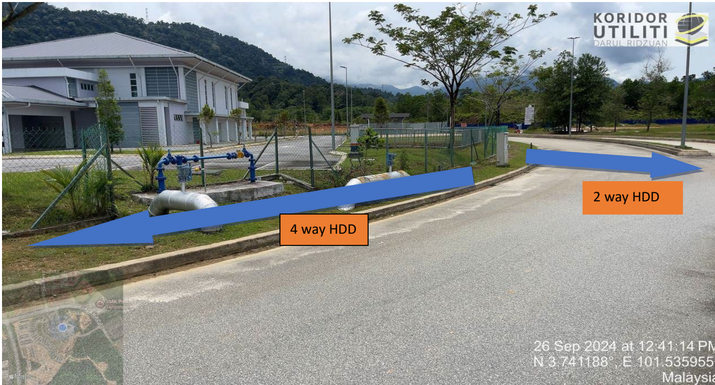
KORDINAT:3741188 101.535955 LOKASI JALAN PARCEL 18
