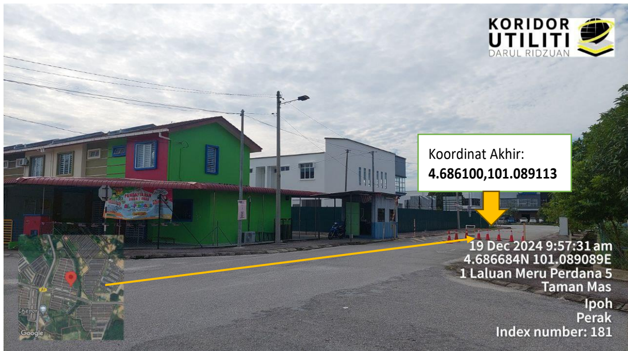
KOREKAN TERBUKA SEPANJANG 82 METER
