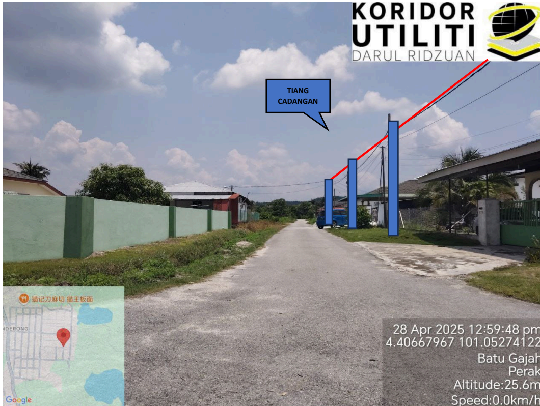
JAJARAN PENANAMAN TIANG DI KAMPUNG BARU CHENDERONG
