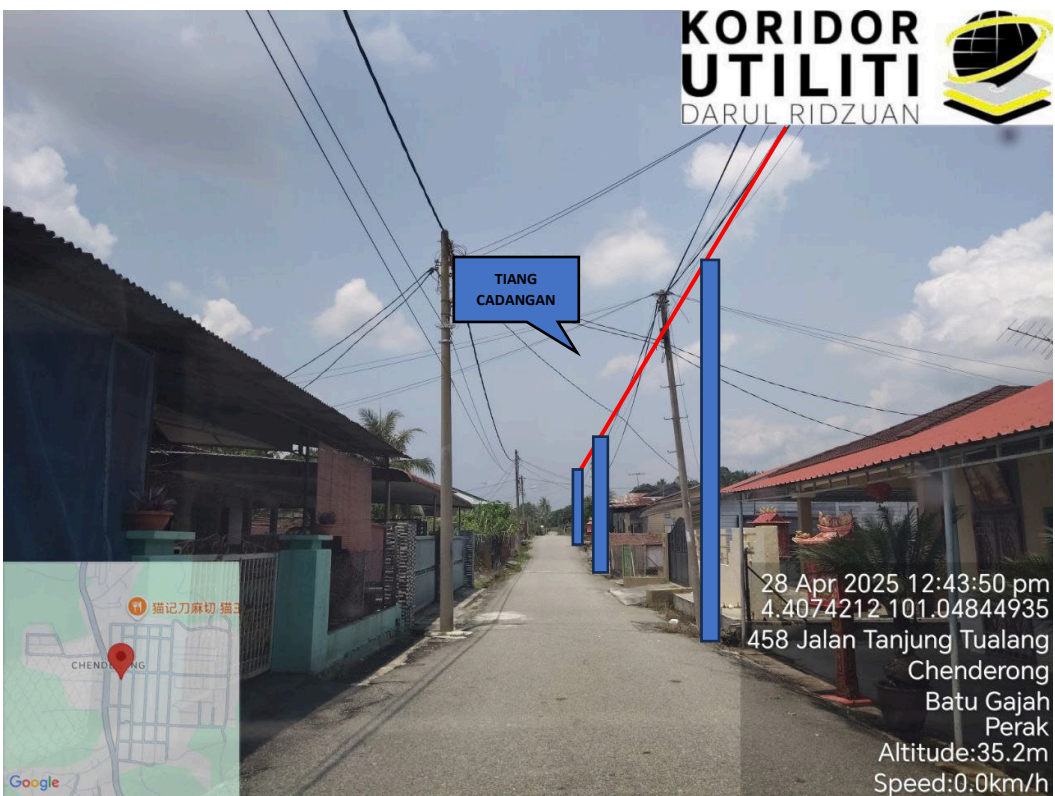
JAJARAN PENANAMAN TIANG DI KAMPUNG BARU CHENDERONG
