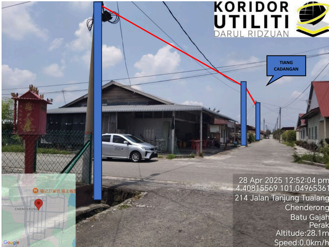
JAJARAN PENANAMAN TIANG DI KAMPUNG BARU CHENDERONG
