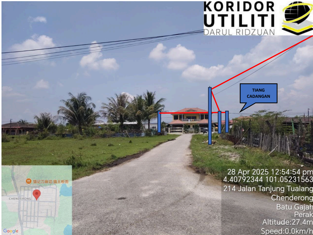
JAJARAN PENANAMAN TIANG DI KAMPUNG BARU CHENDERONG
