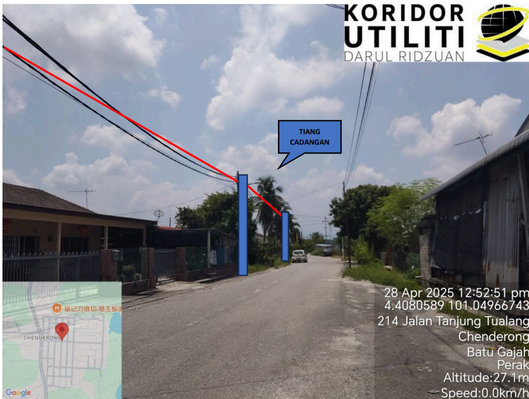
JAJARAN PENANAMAN TIANG DI KAMPUNG BARU CHENDERONG
