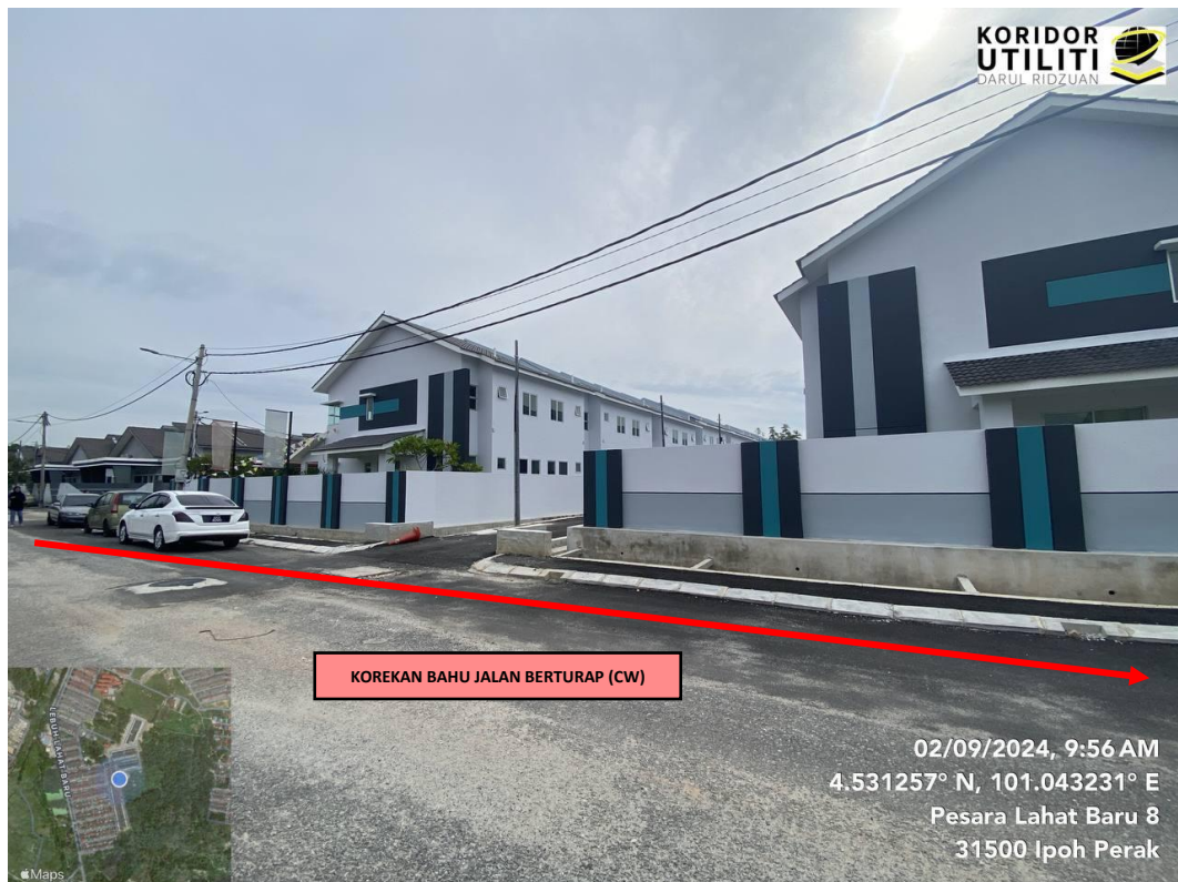
LALUAN KOREKAN TERBUKA DI JALAN SRI WANG 27
