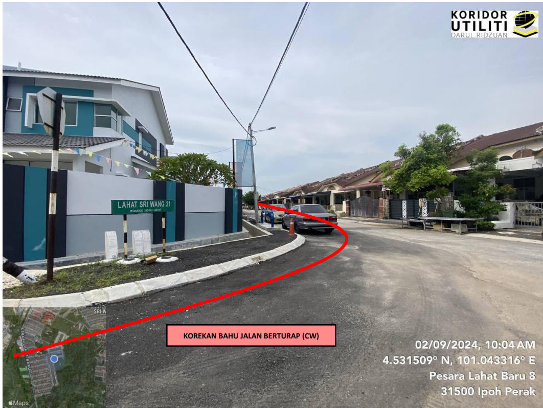
LALUAN KOREKAN TERBUKA DI JALAN SRI WANG 21
