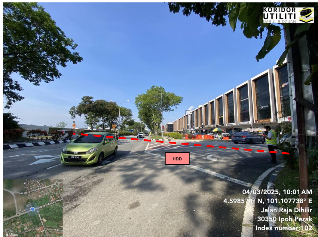
JAJARAN KERJA HDD DI JALAN RAJA DIHILIR
