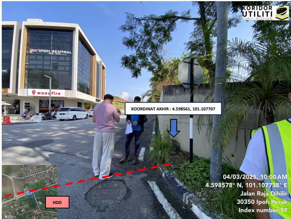
LOKASI KOORDINAT AKHIR KERJA HDD DI JALAN RAJA DIHILIR
