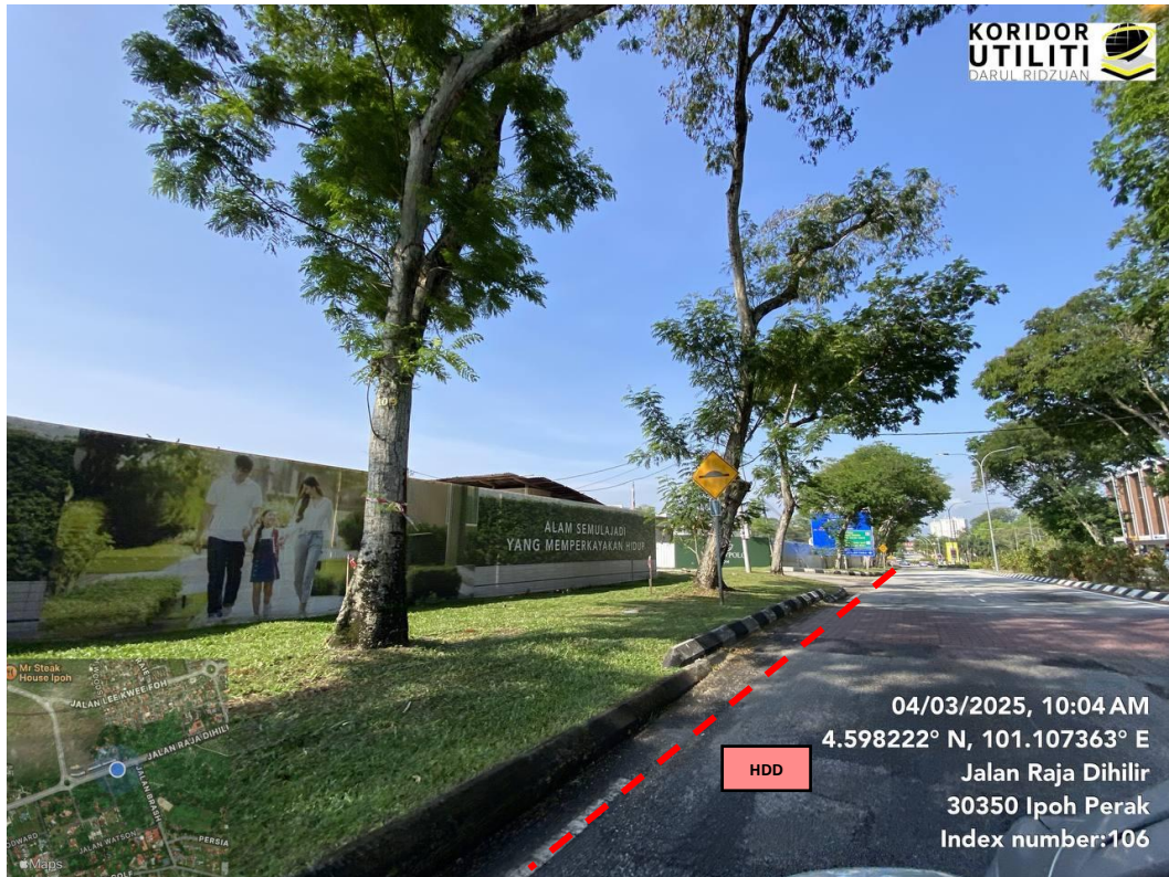
JAJARAN KERJA HDD DI JALAN RAJA DIHILIR
