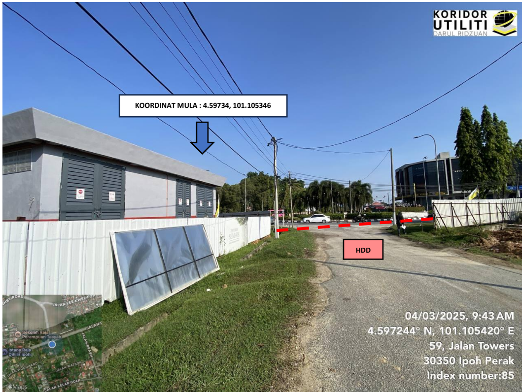
LOKASI KOORDINAT MULA KERJA HDD DI JALAN TOWER
