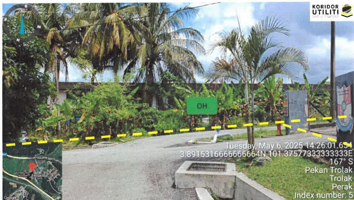
RAJAH 2 : CROSSING JALAN DI KAMPUNG TROLAK PEKAN
