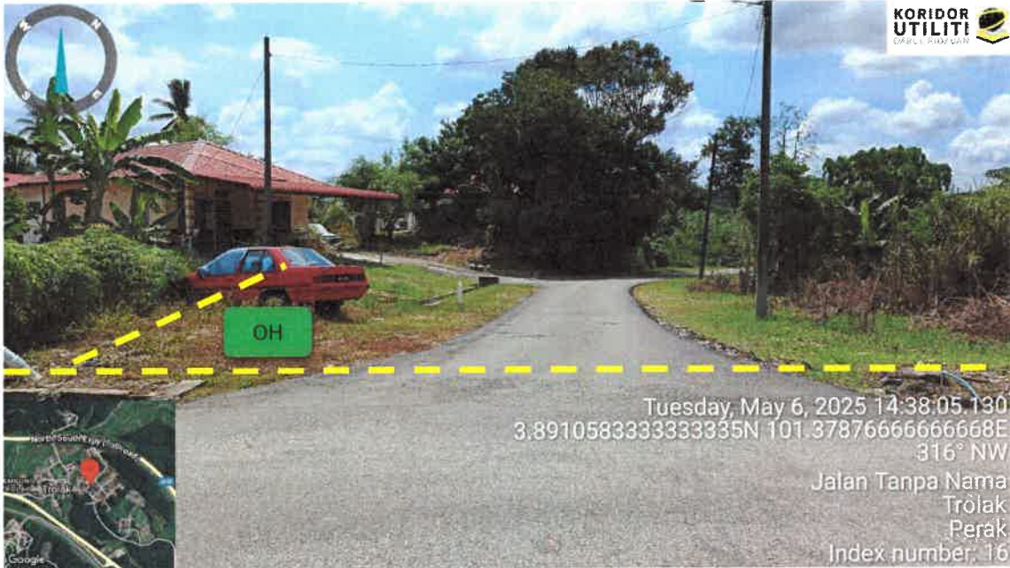
RAJAH 15 : CROSSING JALAN DI KAMPUNG TROLAK PEKAN
