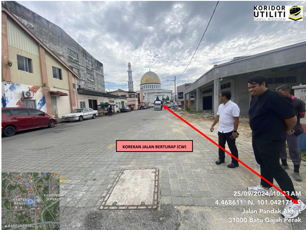
Laluan korekan jalan berturap (CW) di Jalan Haji Mohammad
