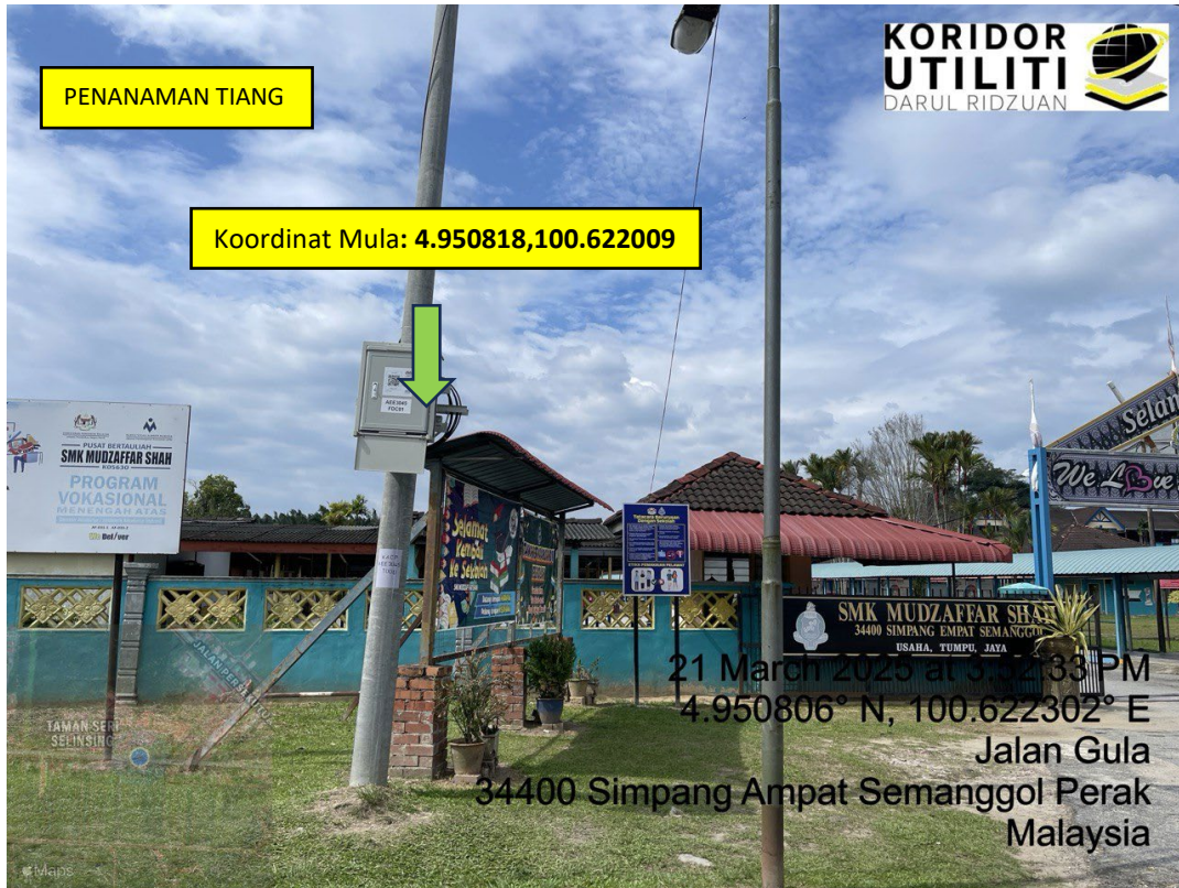
LOKASI DI JALAN GULA
