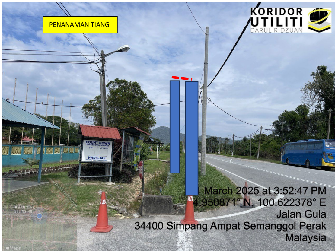
LOKASI DI JALAN GULA
