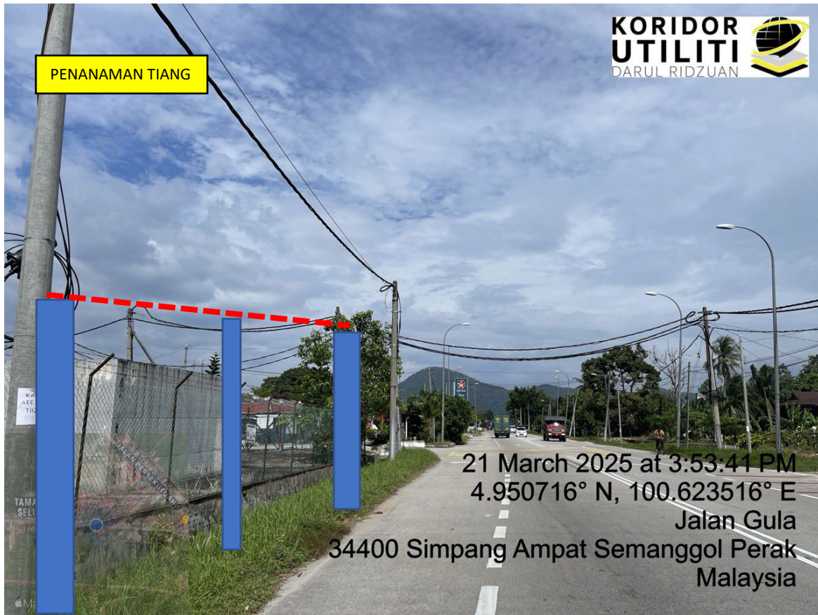
LOKASI DI JALAN GULA
