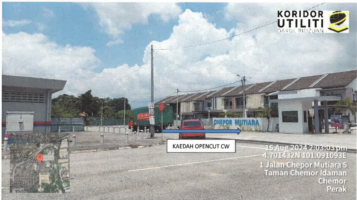
LOKASI KAEDAH OPEN CUT CW : JALAN CHEPOR MUTIARA
