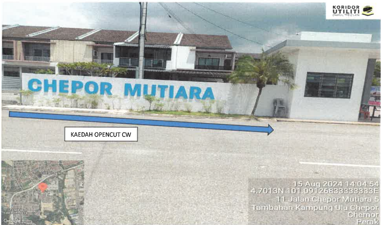
LOKASI KAEDAH OPEN CUT CW : JALAN CHEPOR MUTIARA
