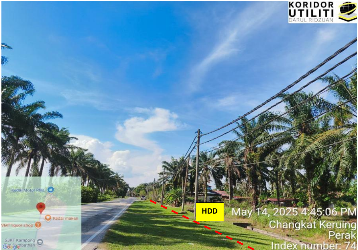
JALAN CHANGKAT KERUING
