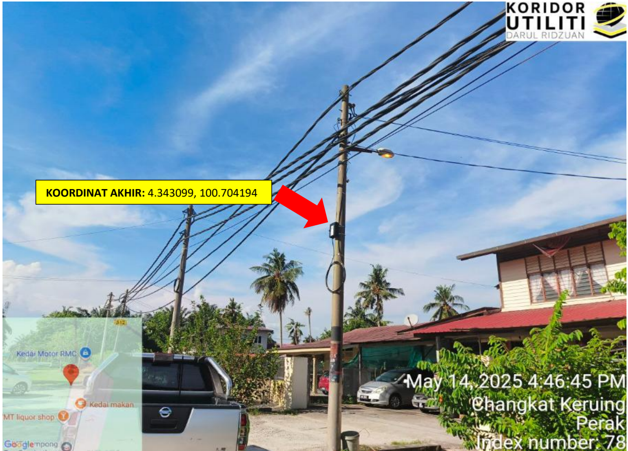
JALAN CHANGKAT KERUING
