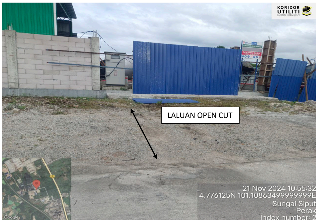
LALUAN OPEN CUT - JALAN SUNGAI SIPUT
