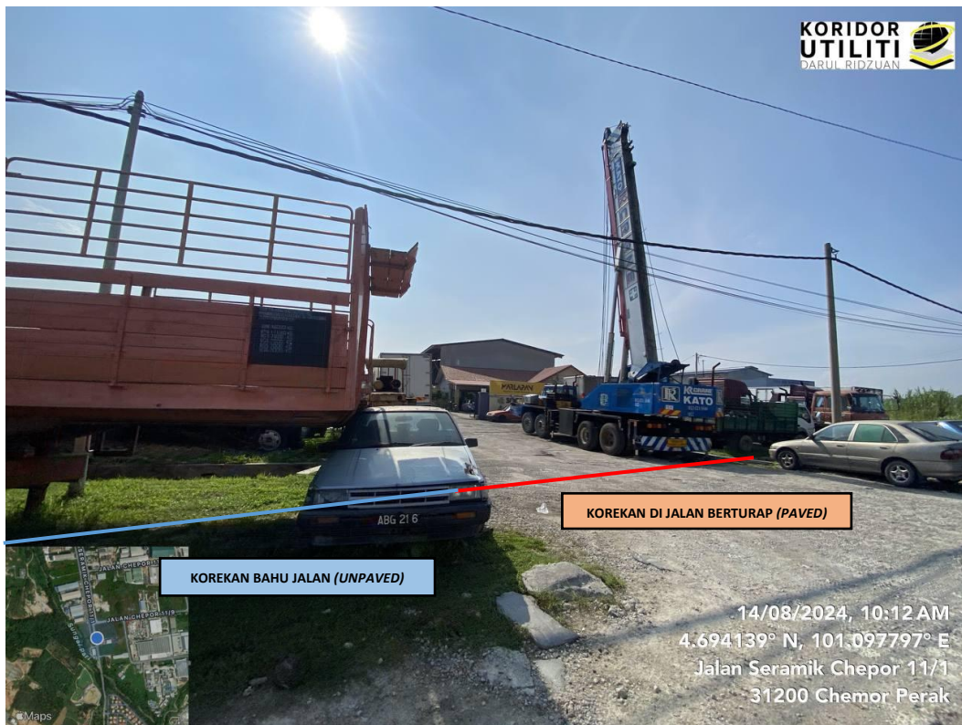
LOKASI KOREKAN GV DAN CW DI JALAN SERAMIK CHEPOR 11/1
